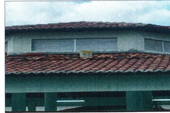
EMASSAMENTO DE CUMEEIRA
