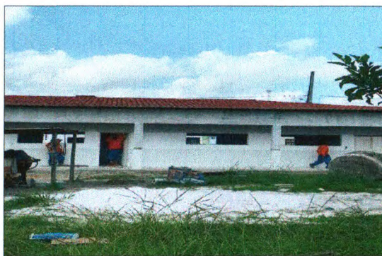
EMASSAMENTO DE CUMEEIRA
