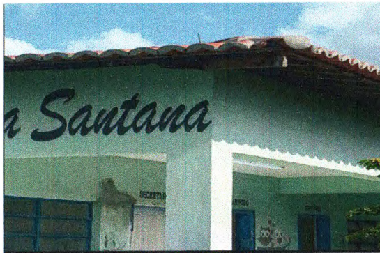
EMASSAMENTO DE BEIRAL
