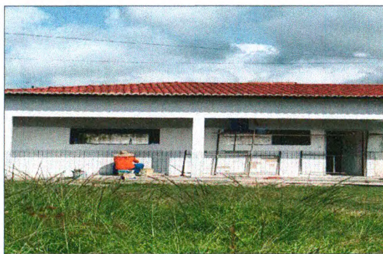
EMASSAMENTO DE BEIRAL
