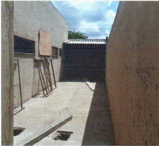
Piso em concreto, caixa de esgoto e caixa de drenagem
