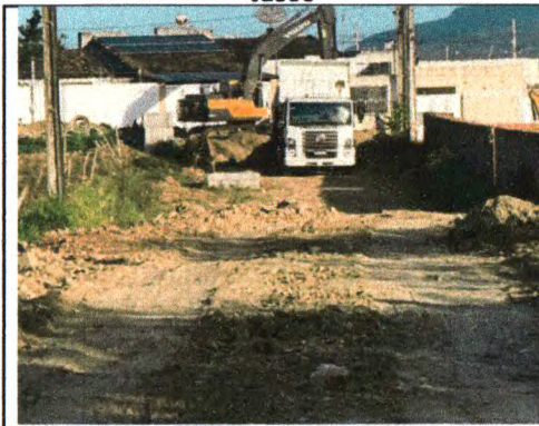
SUB BASE ESTABILIZADA - TRAVESSA IVAN ANDRADE
