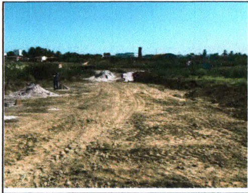
SERVIÇOS PRELIMINARES - RUA PROJETADA B
