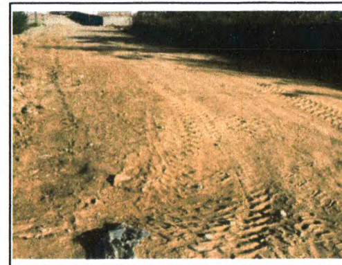
SUB BASE ESTABILIZADA - RUA PROJETADA
