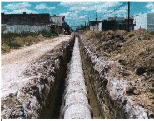
DRENAGEM PROFUNDA - ESCAVAÇÃO E ASSENTAMENTO DE TUBULAÇÃO
