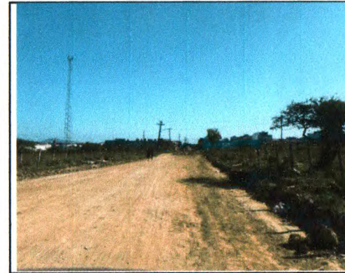
SUB BASE ESTABILIZADA - RUA PADRE FELISMINO
