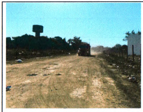
SUB BASE ESTABILIZADA - RUA JOSÉ BRAZ DOS SANTOS
