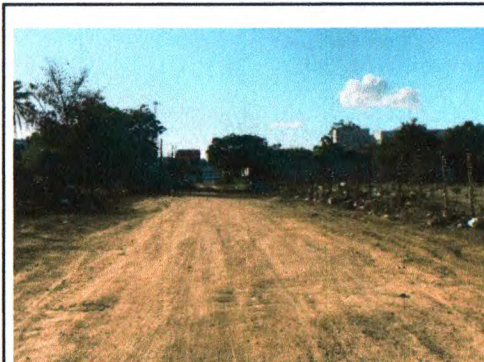
SUB BASE ESTABILIZADA - RUA PEDRO BARBOSA DE JESUS
