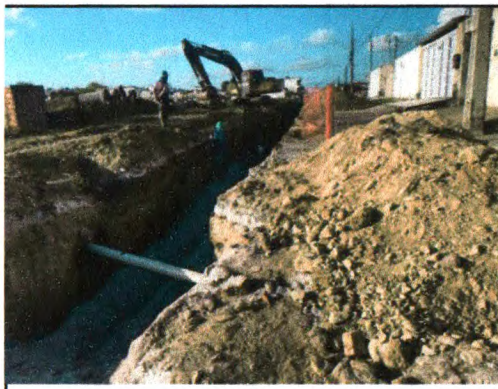
DRENAGEM PROFUNDA - ESCAVAÇÃO E ASSENTAMENTO DE TUBULAÇÃO
