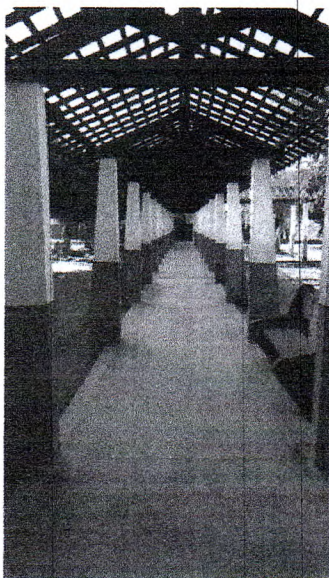
Fotos 15. Retirada de toda a cobertura (telhas) da área de circulação, para fins de verificação do madeiramento, com a instalação de telhas novas, conforme imagens anteriores.
