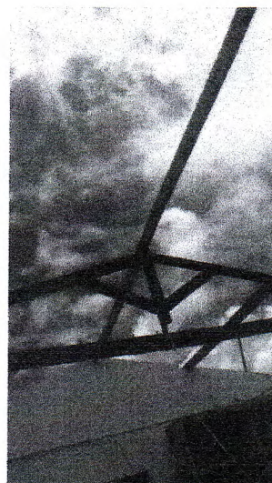
Fotos 13. Realização da substituição do madeiramento do telhado do refeitório com instalação de novas ripas e ripões
