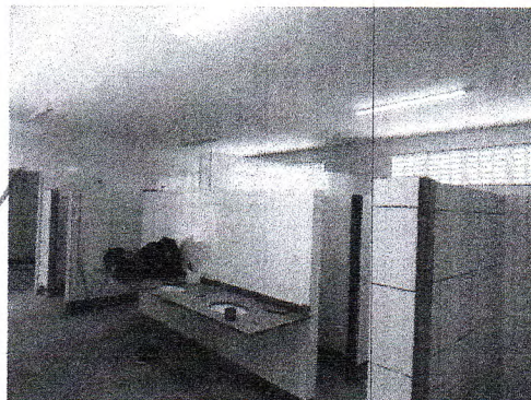
Fotos 04. Instalação de bancada de granito e revestimento nos vestiários. Preparação de base para piso. Instalação de luminárias
