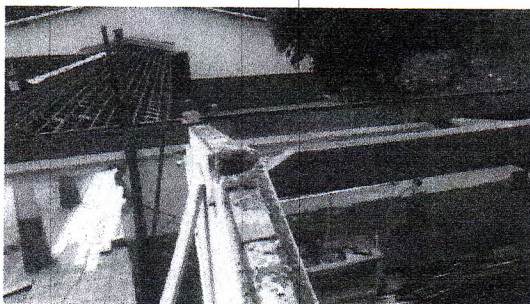
Fotos 13. Realização da substituição do madeiramento do telhado do refeitório com instalação de novas ripas e ripões
