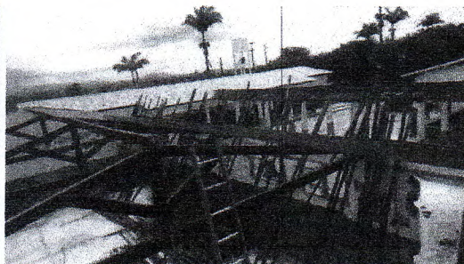
Fotos 11. Demolição de piso de alta resistência; retirada de peças de madeira do telhado para substituição; realização de chapisco e reboco nas paredes. Remoção de forro de pvc de todo o refeitório.
