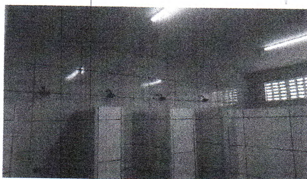
Fotos 06. Instalação dos chuveiros dos vestiários; luminárias acesas; pintura de forro de gesso
