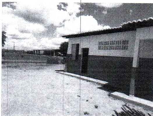
Fotos 03. Parte externa do Bloco dos Vestiários: recuperação dos pilares, emassamento e pintura dos pilares, instalação de janela de alumínio, emassamento de cumieira.
