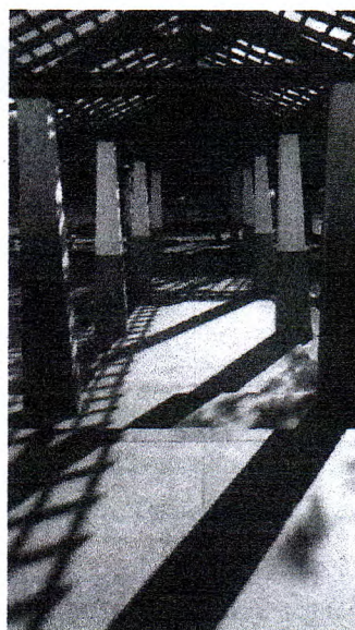
Fotos 15. Retirada de toda a cobertura (telhas) da área de circulação, para fins de verificação do madeiramento, com a instalação de telhas novas, conforme imagens anteriores.
