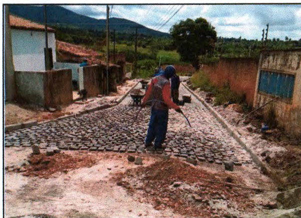
PAVIMENTAÇÃO DO TRECHO 04
