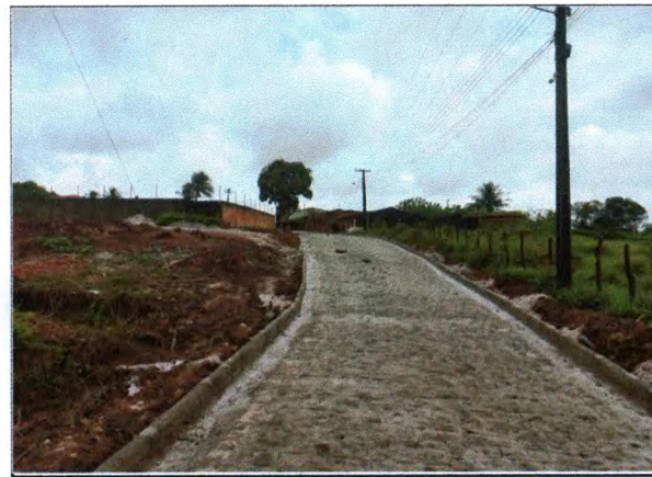
PAVIMENTAÇÃO DO TRECHO 04
