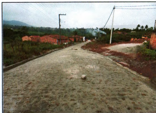
PAVIMENTAÇÃO DO TRECHO 04
