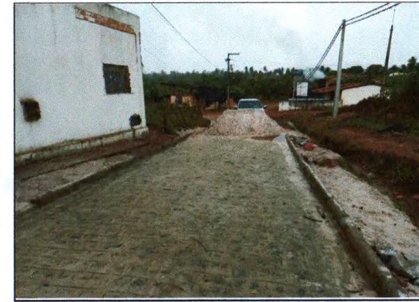
PAVIMENTAÇÃO DO TRECHO 04
