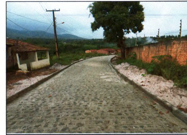
PAVIMENTAÇÃO DO TRECHO 04
