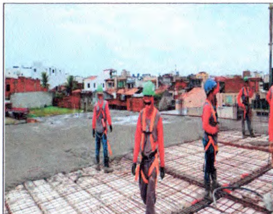
AÇO E CONCRETO DAS LAJES
