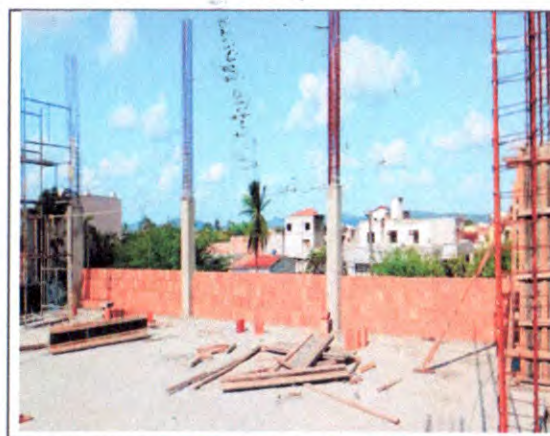
ALVENARIA DE VEDAÇÃO, FORMA, AÇO E CONCRETO DOS PILARES
