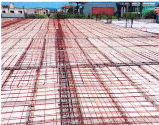
AÇO DAS LAJES
