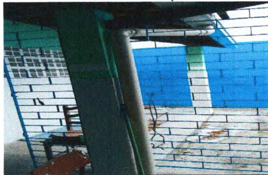
REMOÇÃO DE ESQUADRIA METÁLICA
