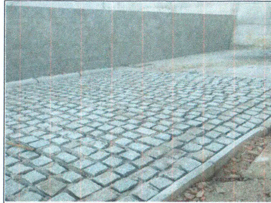
COLCHÃO DE AREIA, MEIO FIO E PARALELEPIPEDO NA TRV. MARIANGA
