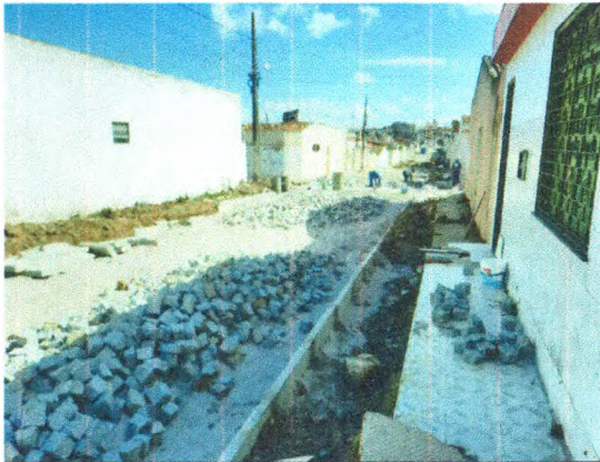
COLCHÃO DE AREIA, MEIO FIO E PARALELEPIPEDO NA RUA MARIA LUIZA MENDONÇA
