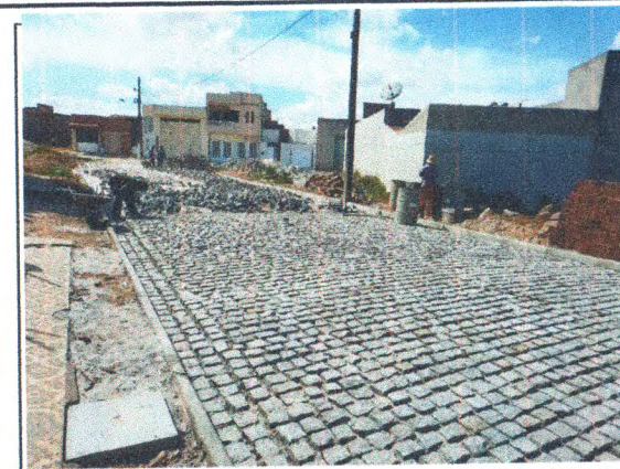
COLCHÃO DE AREIA, MEIO FIO E PARALELEPIPEDO TRECHO DA RUA TERCILIA PASSOS OLIVEIRA
