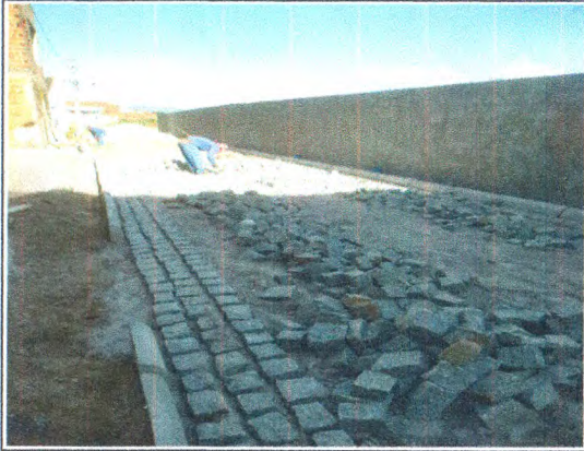
COLCHÃO DE AREIA, MEIO FIO E PARALELEPIPEDO NA TRV. MARIANGA
