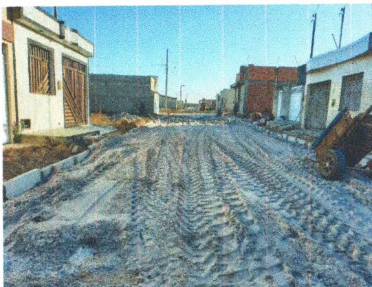
COLCHÃO DE AREIA, MEIO FIO E PARALELEPIPEDO NA RUA ANTÔNIO OLIVEIRA
