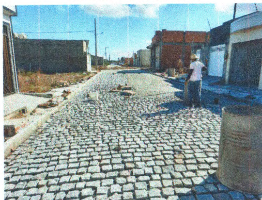
MEIO FIO E PARALELEPIPEDO NA RUA ANTÔNIO OLIVEIRA
