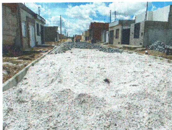
COLCHÃO DE AREIA, MEIO FIO E PARALELEPIPEDO NA RUA ANTÔNIO OLIVEIRA
