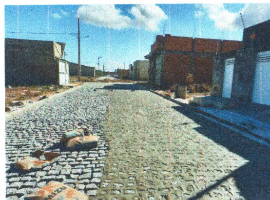
MEIO FIO E PARALELEPIPEDO NA RUA ANTÔNIO OLIVEIRA
