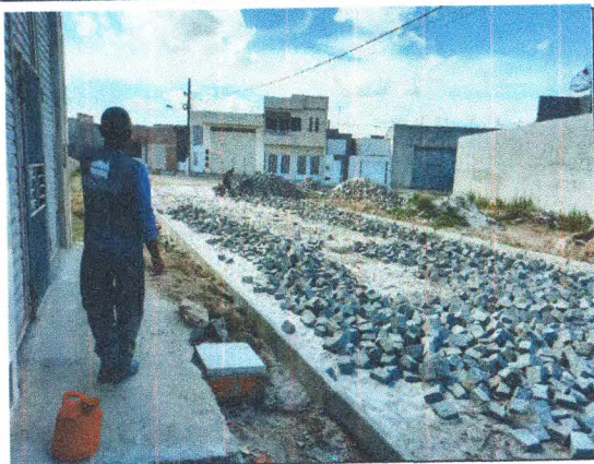
COLCHÃO DE AREIA, MEIO FIO E PARALELEPIPEDO TRECHO DA RUA TERCILIA PASSOS OLIVEIRA
