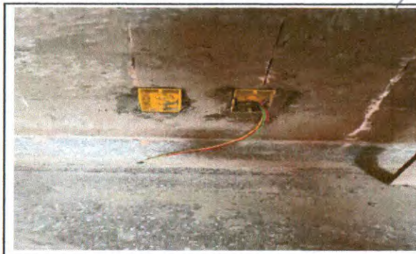
INSTALAÇÃO DOS INTERRUPTORES
