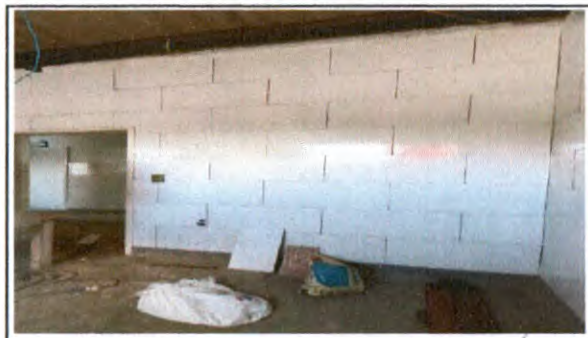
EXECUÇÃO DO REVESTIMENTO
