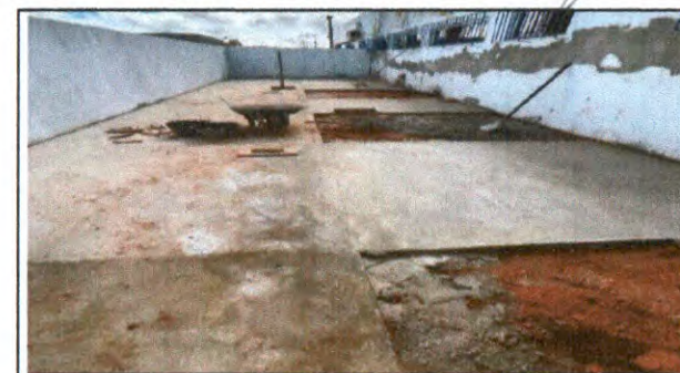
EXECUÇÃO DO PISO DE CONCRETO
