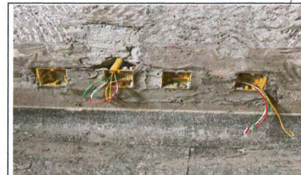
INSTALAÇÃO DAS TOMADAS
