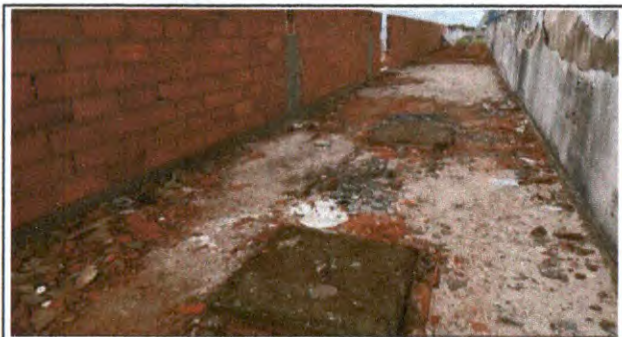
DEMOLIÇÃO DO PISO DE CONCRETO
