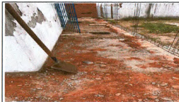
DEMOLIÇÃO DO PISO DE CONCRETO
