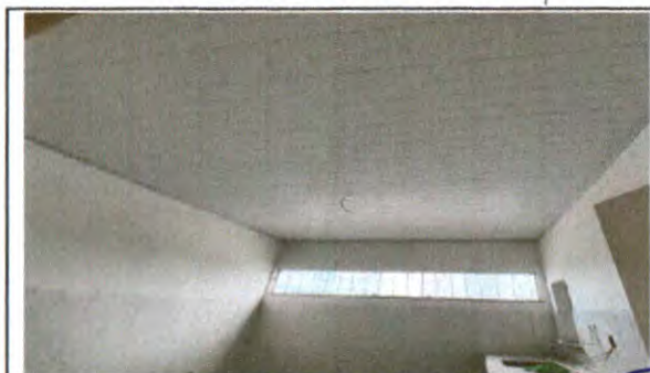
INSTALAÇÃO DO FORRO DE PVC
