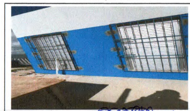
INSTALAÇÃO DAS GRADES
