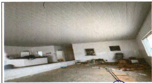
INSTALAÇÃO DO FORRO DE PVC
