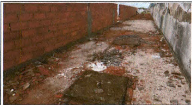
DEMOLIÇÃO DO PISO DE CONCRETO
