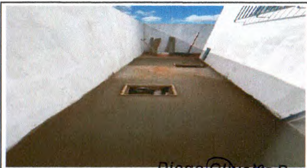
EXECUÇÃO DO PISO DE CONCRETO
