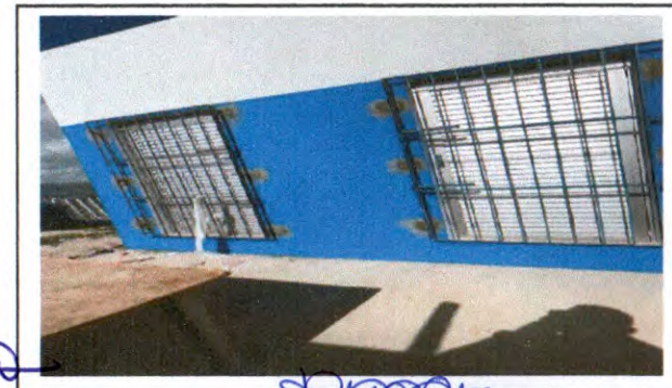
INSTALAÇÃO DAS GRADES
