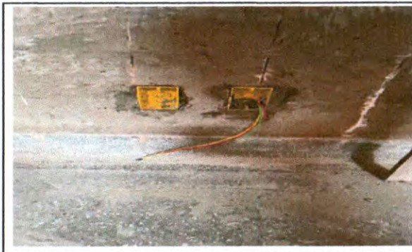
INSTALAÇÃO DOS INTERRUPTORES
