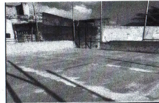
REGULARIZAÇÃO DE BASE
