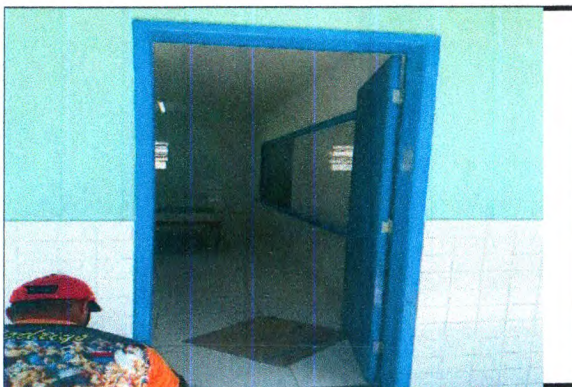
PINTURA INTERNA E PINTURA SOBRE MADEIRA
