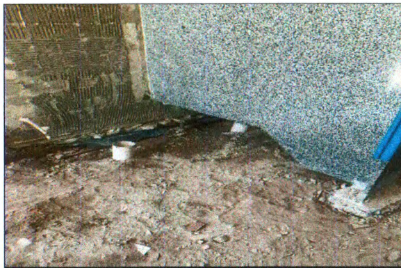
DEMOLIÇÃO MANUAL DE PISO
