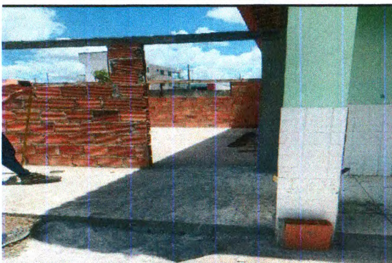
ALVENARIA DE BLOCO
