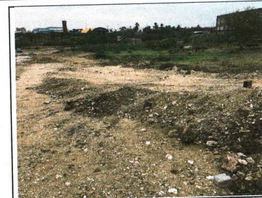
SUB BASE ESTABILIZADA - RUA PROJETADA B
