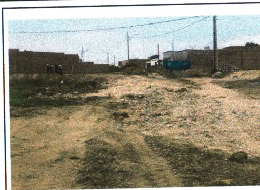
SUB BASE ESTABILIZADA - RUA PROJETADA B
