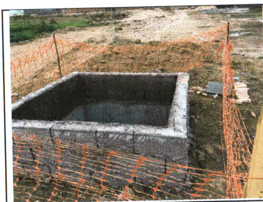
CAIXA DE PASSAGEM E SINALIZAÇÃO
