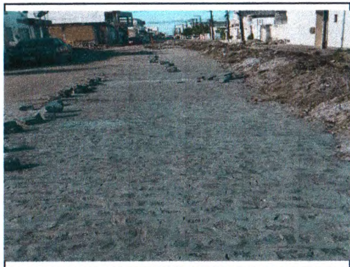
REMOÇÃO E REASSENTAMENTO
