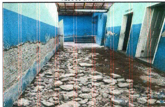
DEMOLIÇÃO PISO ALTA RESISTENCIA
