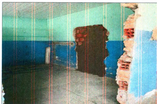
ALVENARIA DE BLOCO
