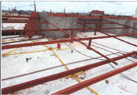
Estrutura do telhado 01
