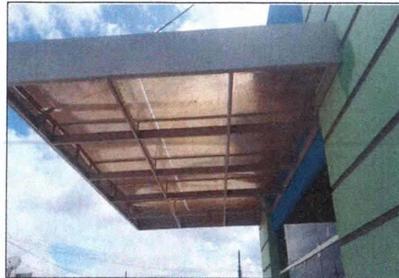
Cobertur em policarbonato 01
