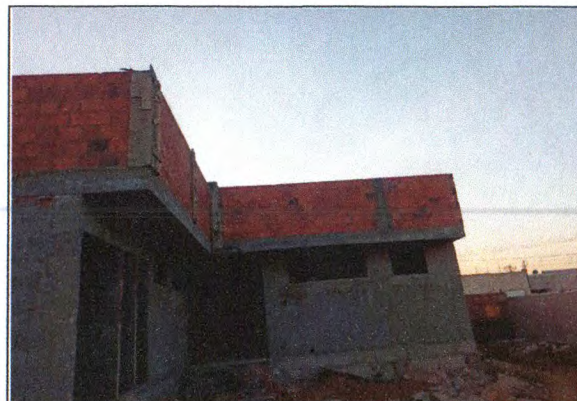
Vigas e laje em balanço 08
