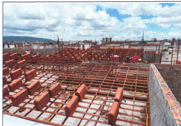
Estrutura do telhado 05
