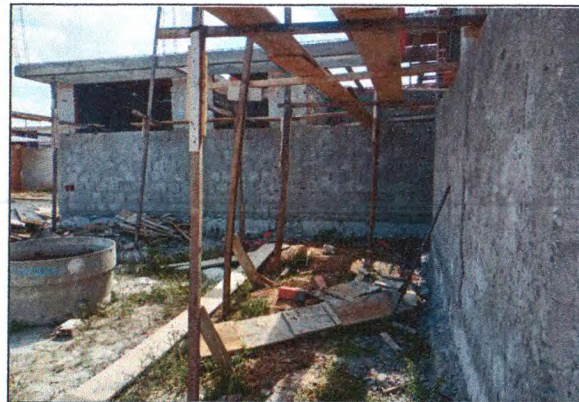
Vigas e laje em balanço 02
