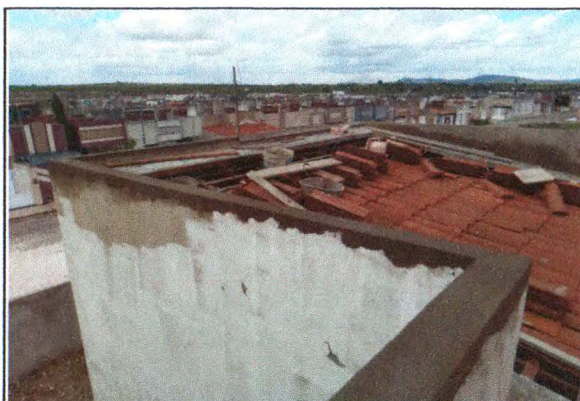
Alvenaria, chapisco e reboco do telhado 01
