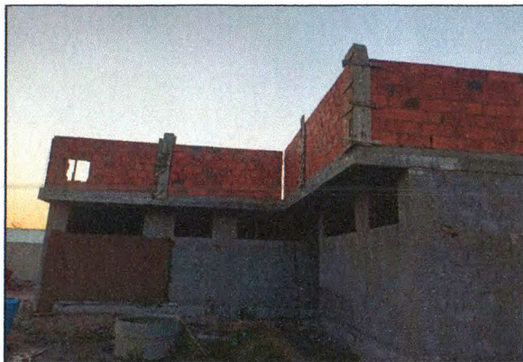
Vigas e laje em balanço 07
