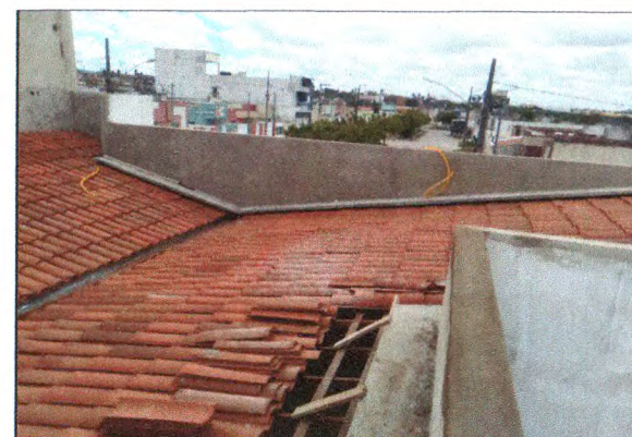
Alvenaria, chapisco e reboco do telhado 03
