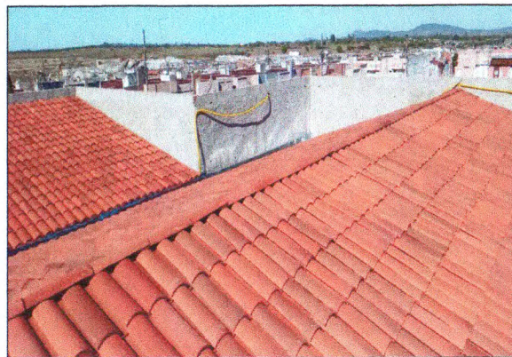
Estrutura do telhado 08
