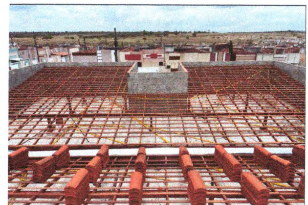
Estrutura do telhado 03
