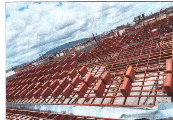
Estrutura do telhado 06
