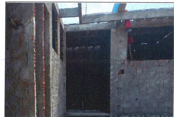
Vigas e laje em balanço 03
