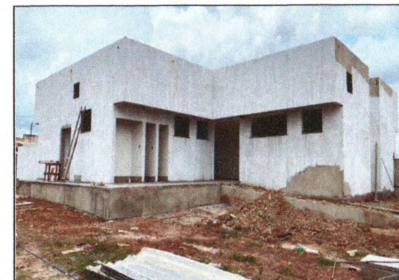
Reboco externo do alicerce
