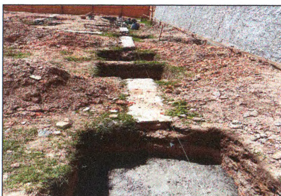
Alvenaria de pedra 01
