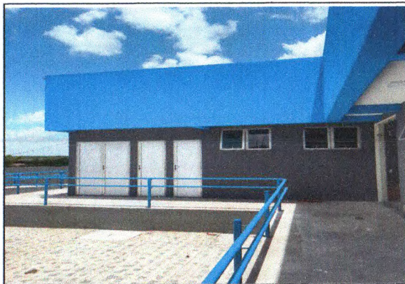
Textura, pintura externa e corrimão
