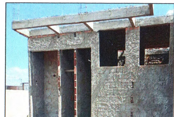
Vigas e laje em balanço 06
