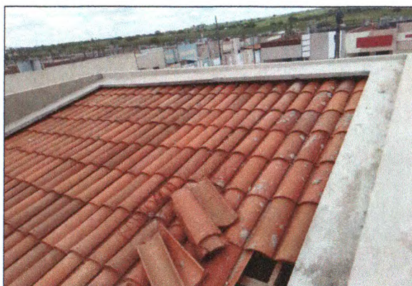
Alvenaria, chapisco e reboco do telhado 02
