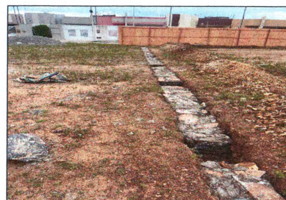
Alvenaria de pedra 02
