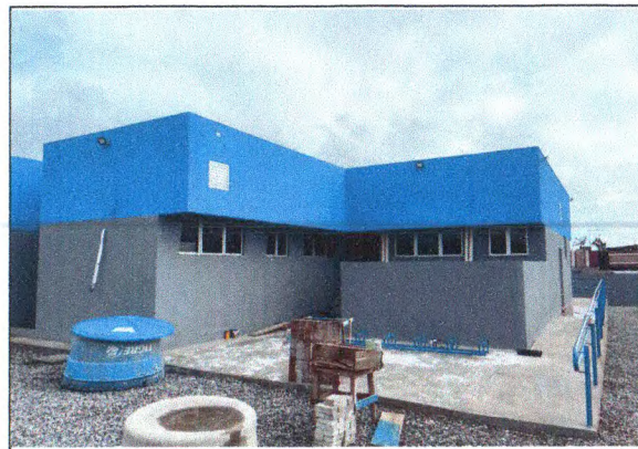
Pintura e portas de alumínio do telhado
