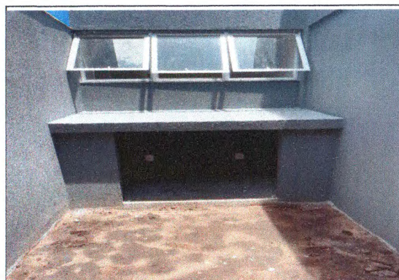
Textura e pintura externa 02
