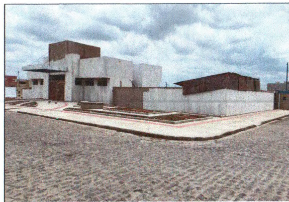
Selador, calçada e piso tátil 01
