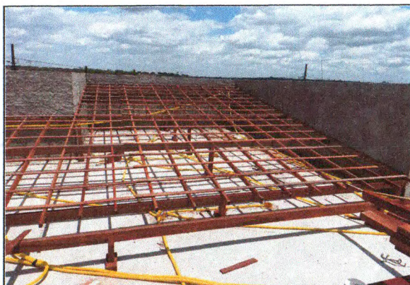
Estrutura do telhado 04
