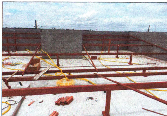
Estrutura do telhado 02
