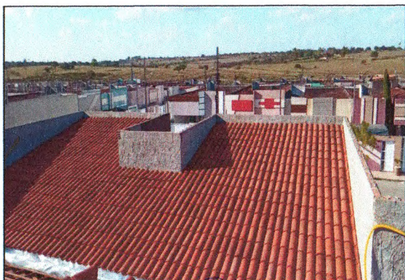
Estrutura do telhado 07
