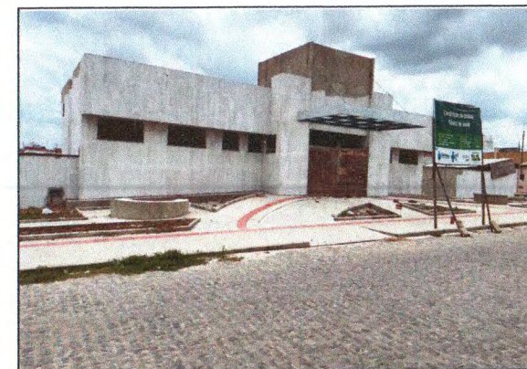
Selador, calçada e piso tátil 02
