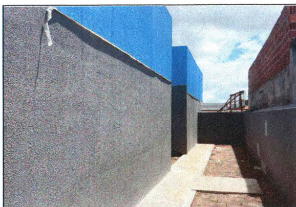
Textura e pintura externa 01
