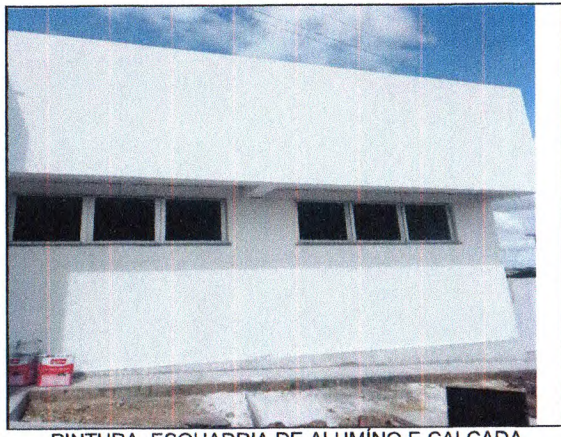
PINTURA, ESQUADRIA DE ALUMINO E CALÇADA
