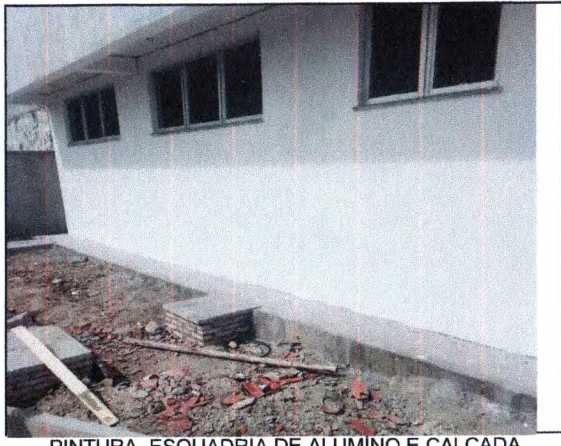
PINTURA, ESQUADRIA DE ALUMINO E CALÇADA
