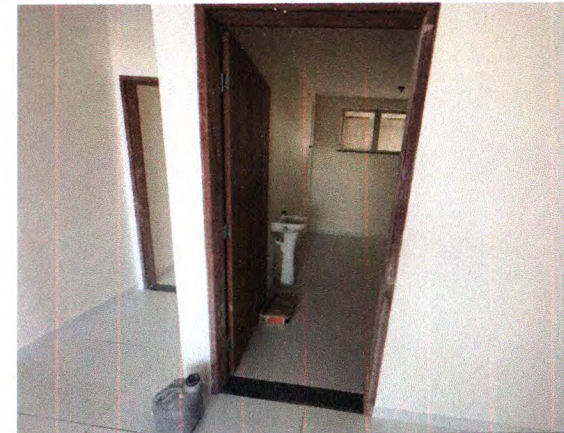
LAVATÓRIO, PORTAS E EMASSAMENTO
