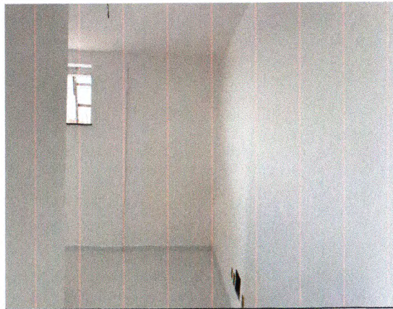
EMASSAMENTO E PONTOS ELÉTRICOS
