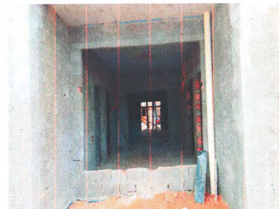
CHAPISCO E REBOCO INTERNO; DRENAGEM PLUVIAL - TUBO DE DESCIDA EM PVC
