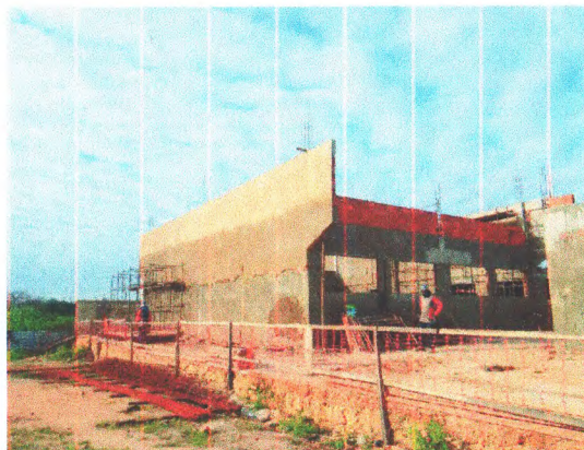
CHAPISCO E REBOCO EXTERNO
