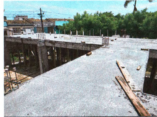
CONCRETAGEM DAS LAJES E VIGAS; INSTALAÇÕES SANITÁRIAS
