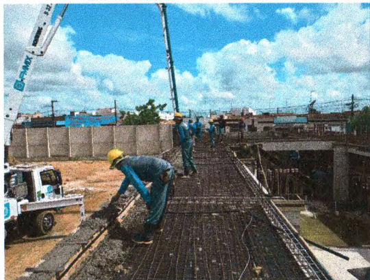
CONCRETAGEM DAS LAJES E VIGAS; INSTALAÇÕES ELÉTRICAS
