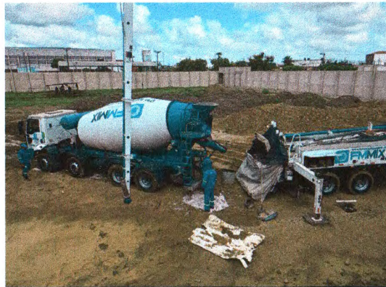
CONCRETAGEM DAS LAJES E VIGAS
