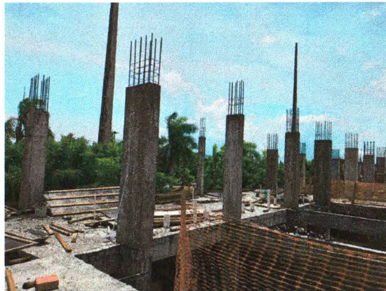
PILARES EM CONCRETO ARMADO; ISOLAMENTO COM TELA DE PVC
