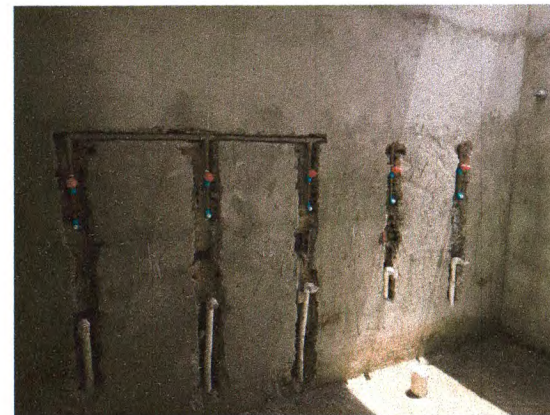
ALVENARIA DE BLOCO CERÂMICO; CHAPISCO; REBOCO EXTERNO; INSTALAÇÕES HIDRO-SANITÁRIAS
