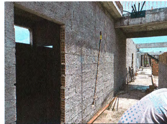
ALVENARIA DE BLOCO CERÂMICO; CHAPISCO; ISOLAMENTO COM TELA DE PVC; INSTALAÇÕES ELÉTRICAS
