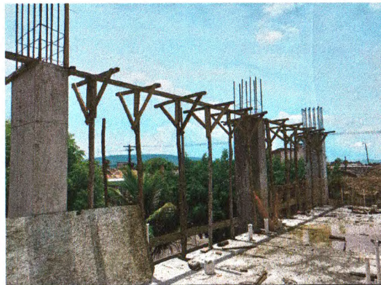
PILARES EM CONCRETO ARMADO; ESCORAMENTO EM MADEIRA PARA AS VIGAS; ISOLAMENTO COM TELA DE PVC
