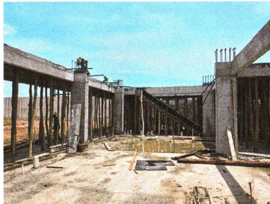
ESCORAMENTO EM MADEIRA PARA AS VIGAS E LAJES
