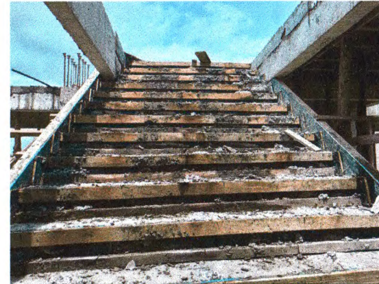
CONCRETAGEM DA ESCADA
