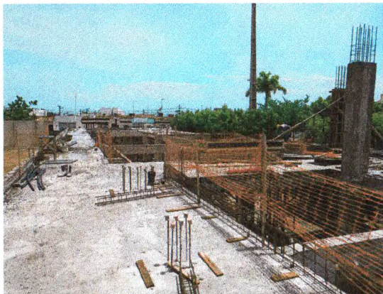
CONCRETAGEM DAS LAJES E VIGAS; ISOLAMENTO COM TELA DE PVC
