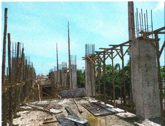
PILARES EM CONCRETO ARMADO; ESCORAMENTO EM MADEIRA PARA AS VIGAS
