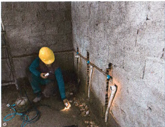
ALVENARIA DE BLOCO CERÂMICO; CHAPISCO; INSTALAÇÕES HIDRO-SANITÁRIAS
