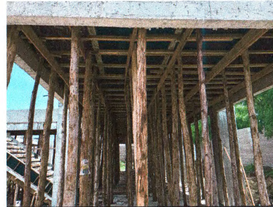
FORMA E ESCORAMENTO DAS LAJES E ESCADA
