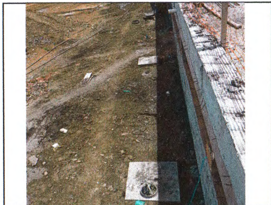
CHAPISCO E REBOCO EXTERNO; CAIXAS DE PASSAGEM EM ALVENARIA E TAMPAS DE CONCRETO
