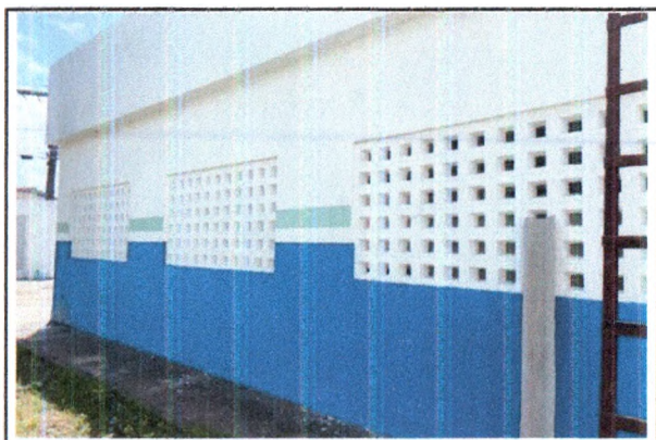
PINTURA DE PAREDES
