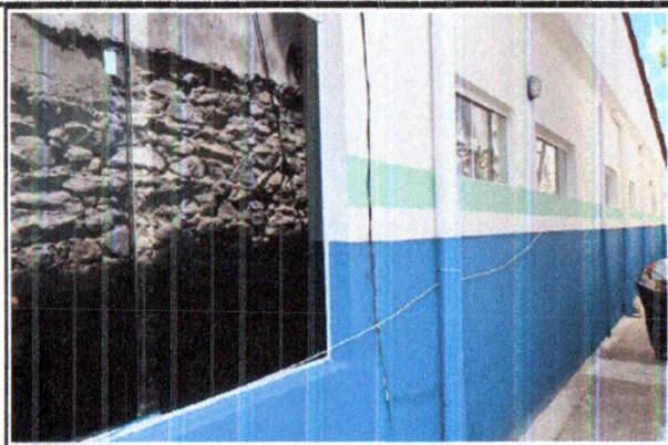
PINTURA DE PAREDES
