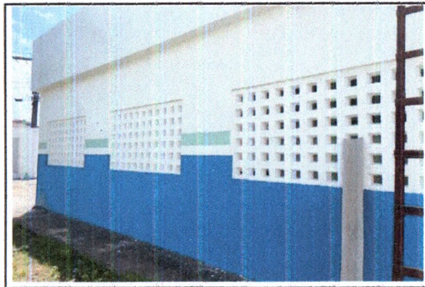
PINTURA DE PAREDES
