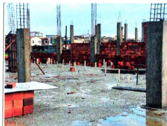
LAJE, PILARES E ALVENARIA DE VEDAÇÃO
