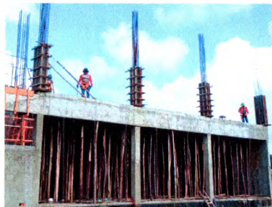
FORMA E ESCORAMENTO DAS LAJES
