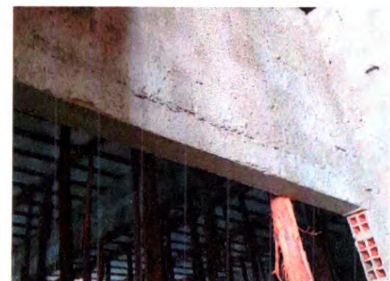
ESCORAMENTO E FORMA DAS LAJES
