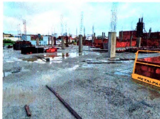
LAJE, CONCRETO E FORMA DOS PILARES, ALVENARIA DE VEDAÇÃO
