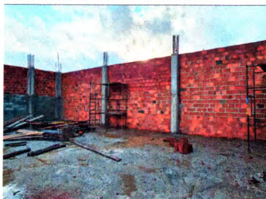
ALVENARIA DE VEDAÇÃO E CONCRETO DOS PILARES
