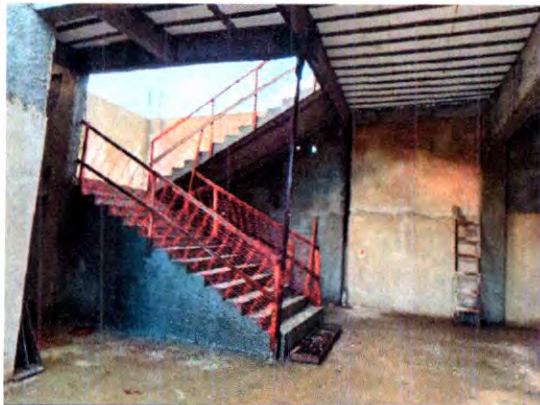
ESCADA E LAJE PRÉ MOLDADA
