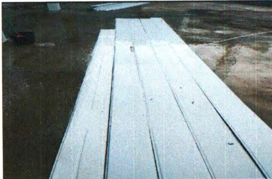
REMOÇÃO DE FORRO
