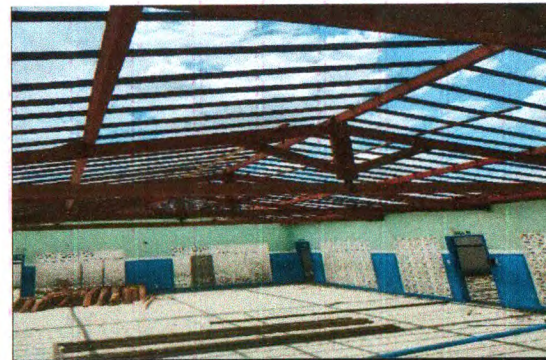
RETIRADA E RECOLOCAÇÃO DE TELHAS
