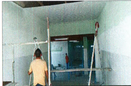
MONTAGEM DE FORRO
