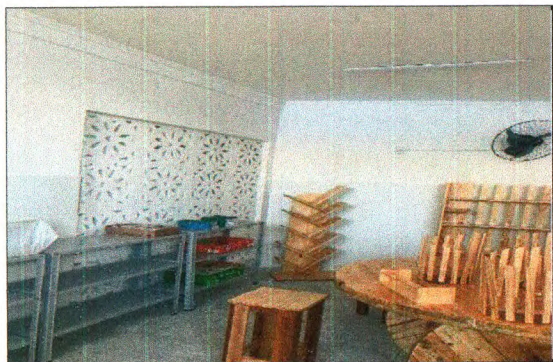
FORRO EM GESSO
