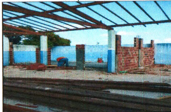
REMOÇÃO DE MADEIRAMENTO RIPAS /RIPÕES
