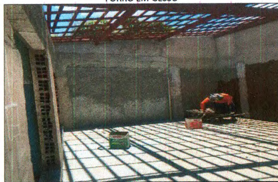
REGULARIZAÇÃO DE BASE
