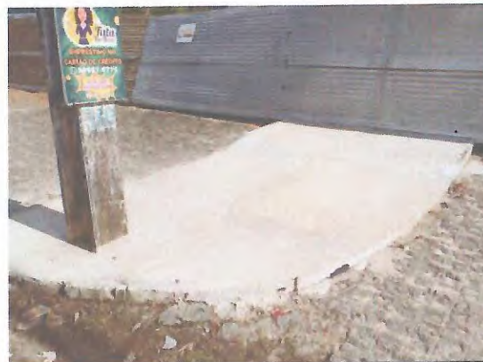
PISO DE CONCRETO
