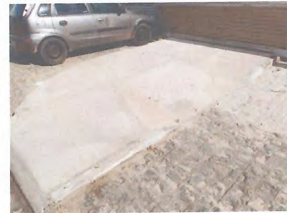
PISO DE CONCRETO
