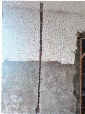
Fotos 04. Apicotamento de paredes, execução de reboco e instalação de caixão de portas
