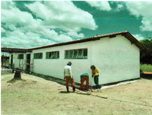
Fotos 09. Emassamento da área externa, aplicação de selador e retelhamento do Bloco do Refeitório
