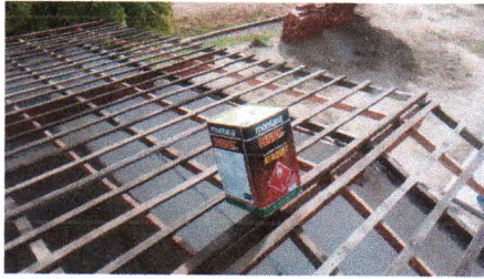
Fotos 03. Imunização do madeiramento do Bloco do Refeitório
