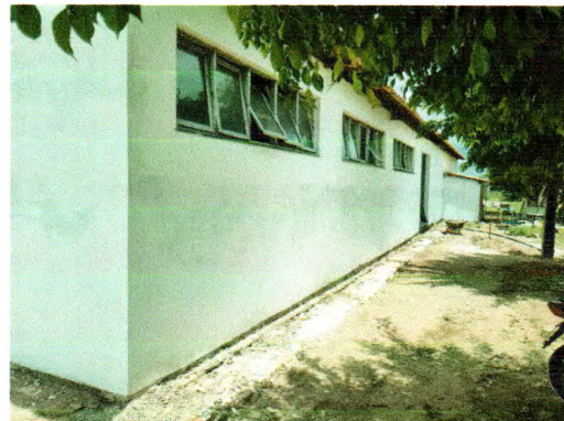
Fotos 09. Emassamento da área externa, aplicação de selador e retelhamento do Bloco do Refeitório
