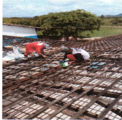
Fotos 03. Imunização do madeiramento do Bloco do Refeitório
