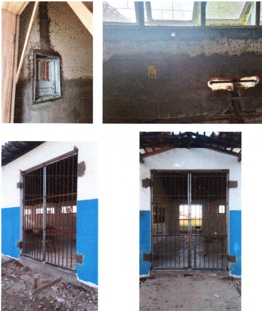
Fotos 07. Instalação de quadro de energia; pontos de água fria e instalação dos portões.
