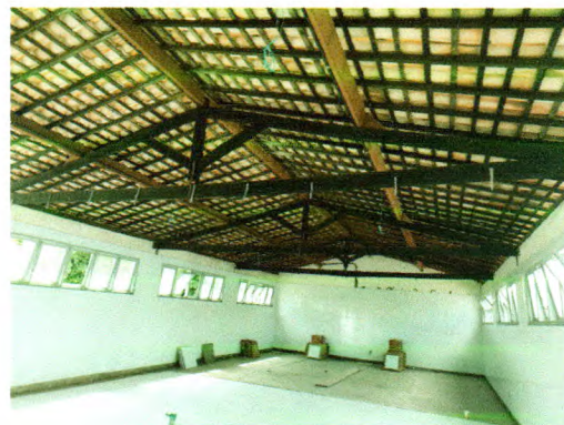
Fotos 13. Execução de piso no Bloco do Refeitório; substituição de madeiramento; instalação de eletrodutos e cabeamento elétrico
