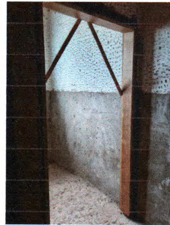
Fotos 04. Apicotamento de paredes, execução de reboco e instalação de caixão de portas
