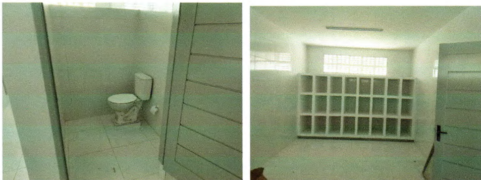
Fotos 02. Instalação de pisos em todo o bloco do vestiário, papelarias e vasos sanitários
