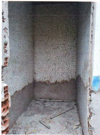
Fotos 04. Apicotamento de paredes, execução de reboco e instalação de caixão de portas
