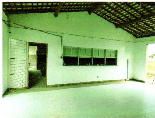
Fotos 12. Execução de revestimento no Refeitório; substituição de peitoris; instalação de caixão de porta
