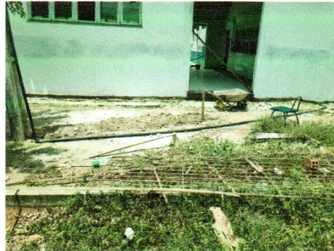
Fotos 08. Eletrodutos e cabeamento do ramal de entrada do Bloco do Refeitório, com instalação de haste de aterramento
