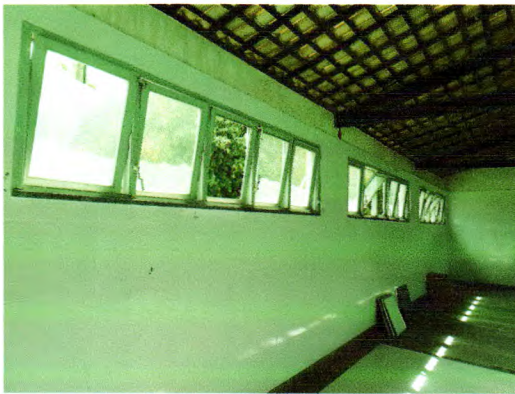
Fotos 12. Execução de revestimento no Refeitório; substituição de peitoris; instalação de caixão de porta
