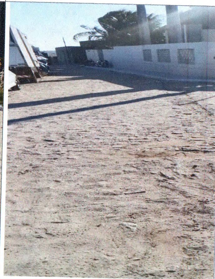
Pintura e Limpeza Trav. Tanque Vermelho 01
