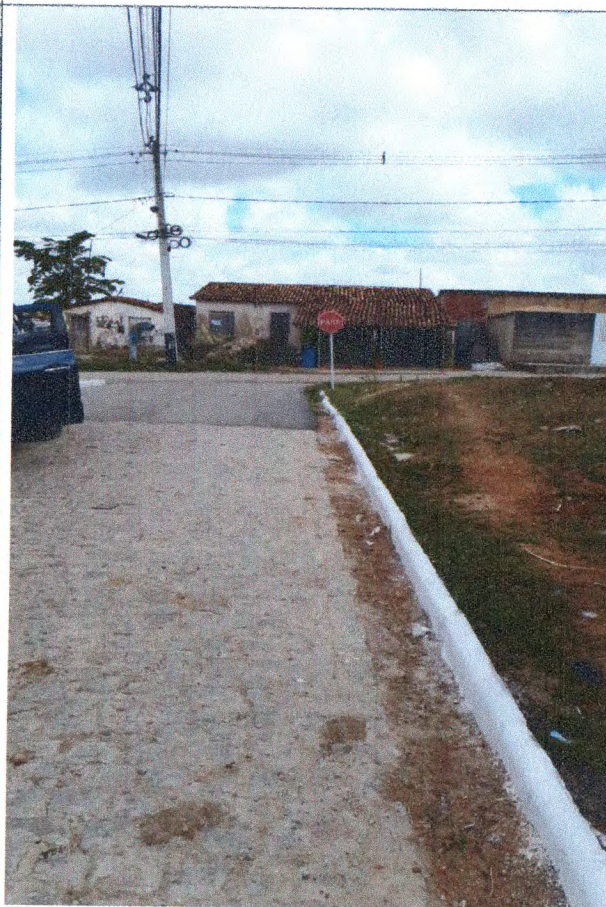
Sinalização TV Tanque Vermelho 4
