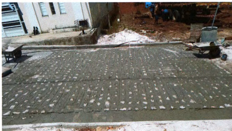
Foto 07: Pavimentação em paralelepípedo granítico sobre colchão de areia.
