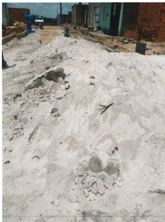
Foto 02: Locação de serviços de pavimentação.
