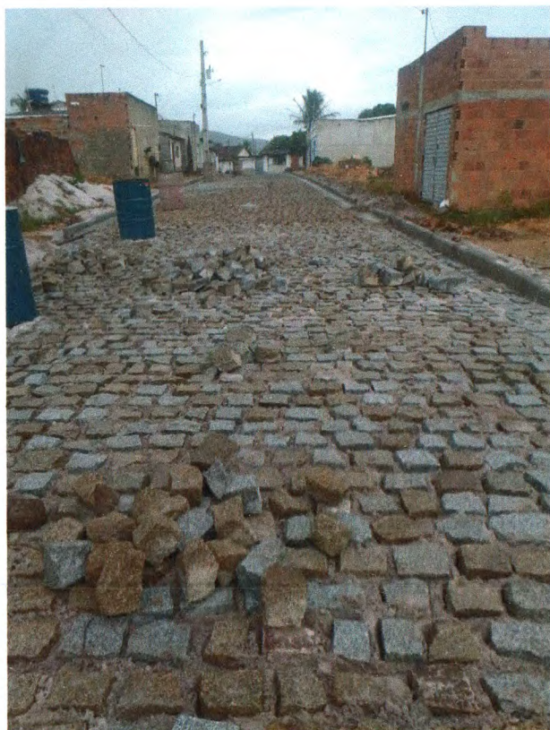
Foto 04: Pavimentação em paralelepípedo granítico sobre colchão de areia.
