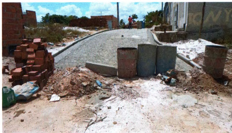
Foto 08: Pavimentação em paralelepípedo granítico sobre colchão de areia.
