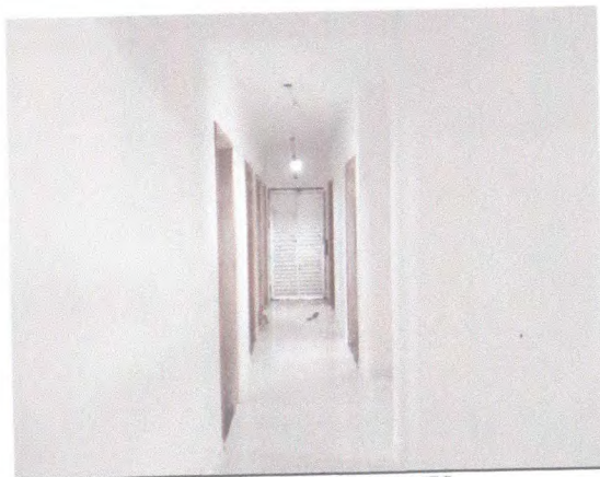
PORTAS E EMASSAMENTO
