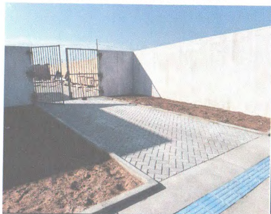
PISO TÁTIL, PAVIMENTAÇÃO EM BLOCOS DE CONCRETO E PINTURA SELADORA
