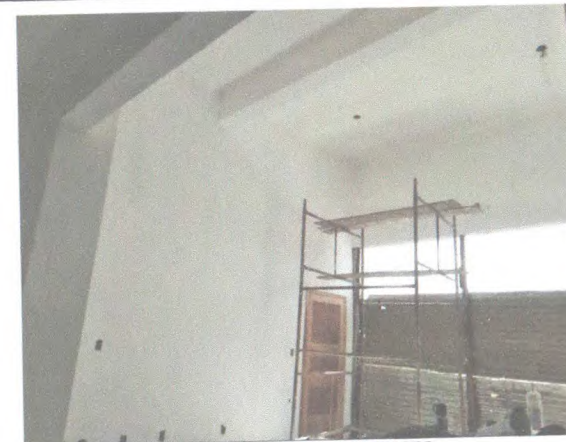
PORTAS E EMASSAMENTO
