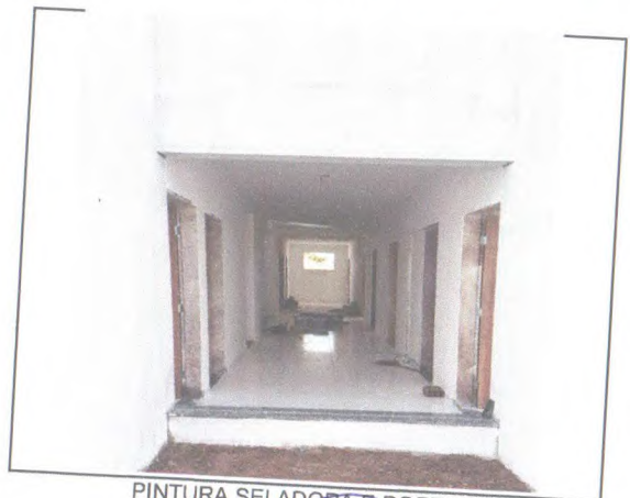
PINTURA SELADORA E PORTAS
