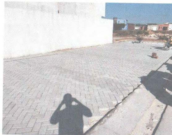
PAVIMENTAÇÃO EM BLOCOS DE CONCRETO E PINTURA SELADORA
