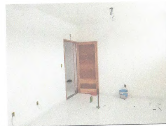
PORTAS E EMASSAMENTO
