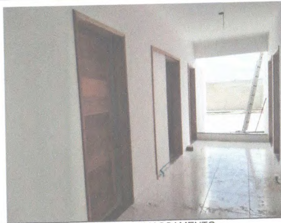
PORTAS E EMASSAMENTO
