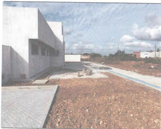
PISO TÁTIL, PAVIMENTAÇÃO EM BLOCOS DE CONCRETO E PINTURA SELADORA
