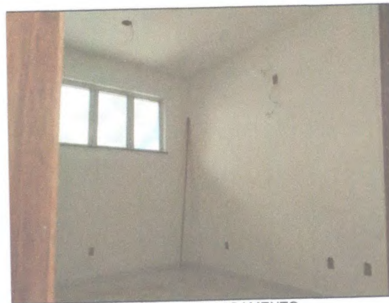
PORTAS E EMASSAMENTO
