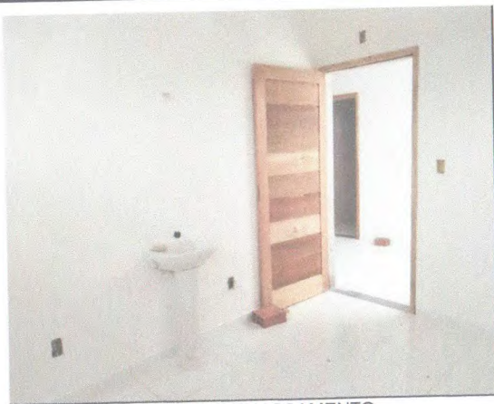
PORTAS E EMASSAMENTO
