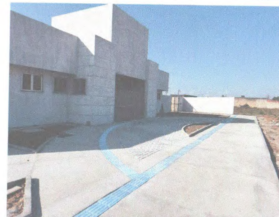
PISO TÁTIL, RAMPAS, PAVIMENTAÇÃO EM BLOCOS DE CONCRETO E PINTURA SELADORA
