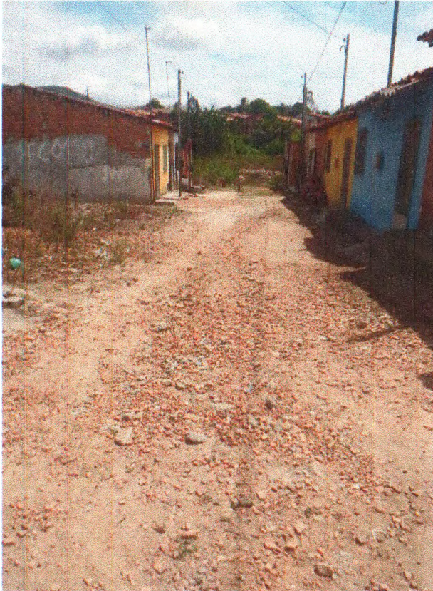
Foto 01: Regularização e compactação de subleito de solo predominantemente arenoso.
