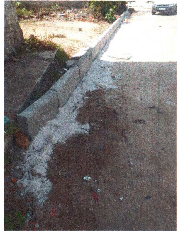
Foto 03: Meio-fio pré-moldado de concreto simples.
