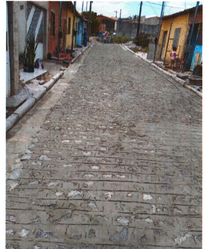
Foto 03: Pavimentação em paralelepípedo granítico sobre colchão de areia.
