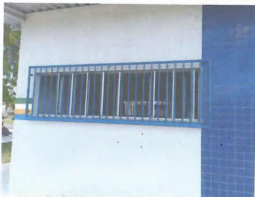
PINTURA PARA EXTERIORES - ADMINISTRAÇÃO
