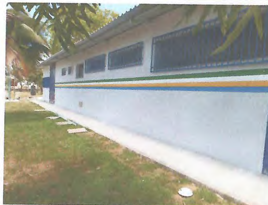
PINTURA PARA EXTERIORES - ADMINISTRAÇÃO
