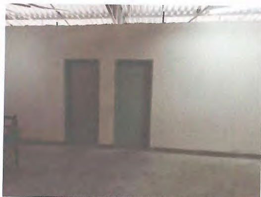
PINTURA VESTIÁRIO E TEATRO ARENA
