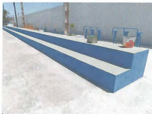
PINTURA DE ARQUIBANCADA
