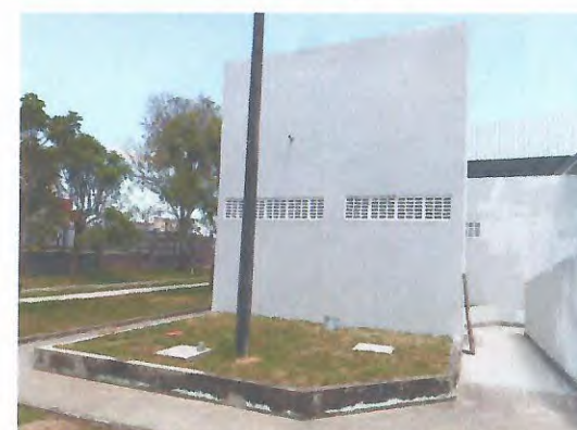
PINTURA PARA EXTERIORES - ADMINISTRAÇÃO
