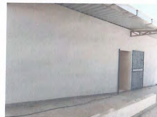
PINTURA VESTIÁRIO E TEATRO ARENA
