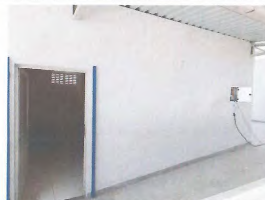
PINTURA VESTIÁRIO E TEATRO ARENA
