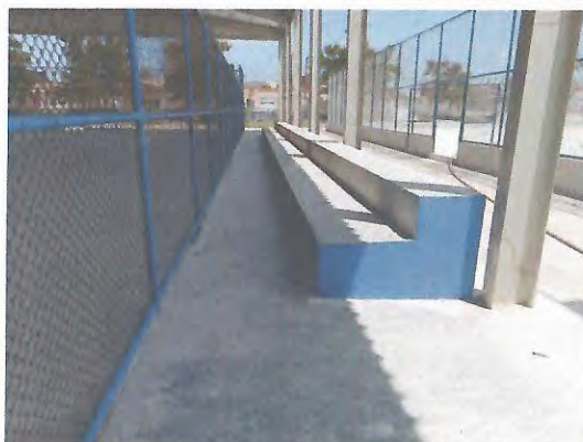
PINTURA DE ARQUIBANCADA
