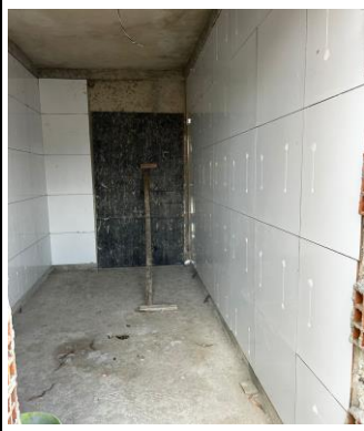
REGULARIZAÇÃO DE BASE PARA PISO
