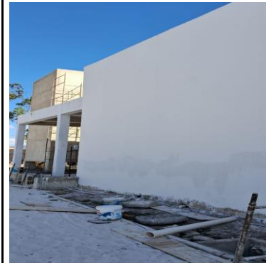
SELADOR E EMASSAMENTO DE PAREDE; IMPERMEABILIZAÇÃO DE COBERTURA
