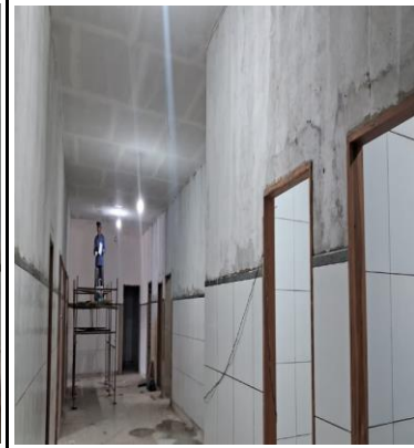
SELADOR E EMASSAMENTO DE PAREDE; PONTOS DE LUMINÁRIAS
