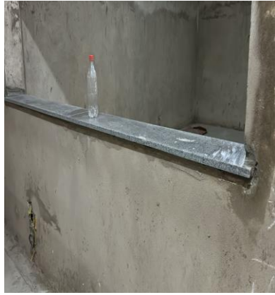
CHAPISCO E REBOCO DE ALVENARIA
