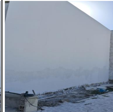
SELADOR E EMASSAMENTO DE PAREDE
