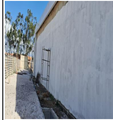
SELADOR E EMASSAMENTO DE PAREDE
