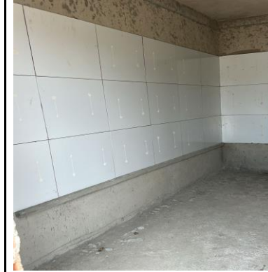
REGULARIZAÇÃO DE BASE PARA PISO
