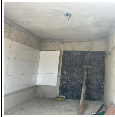
REGULARIZAÇÃO DE BASE PARA PISO
