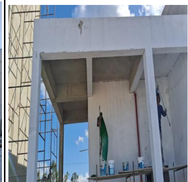
SELADOR E EMASSAMENTO DE PAREDE; IMPERMEABILIZAÇÃO DE COBERTURA
