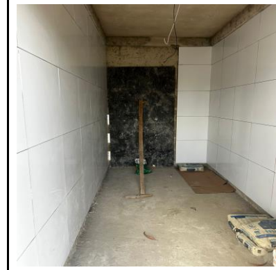
REGULARIZAÇÃO DE BASE PARA PISO
