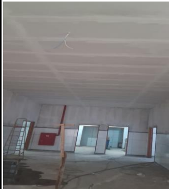
SELADOR E EMASSAMENTO DE PAREDE; PONTOS DE LUMINÁRIAS
