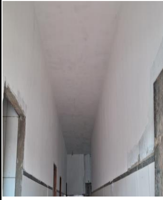
SELADOR E EMASSAMENTO DE PAREDE
