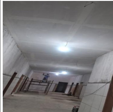
SELADOR E EMASSAMENTO DE PAREDE; PONTOS DE LUMINÁRIAS
