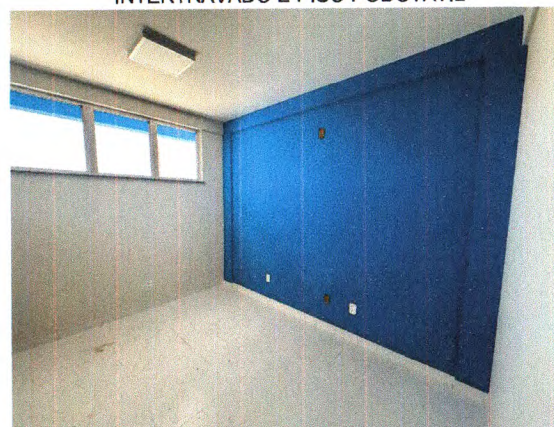
PINTURA E LUMINÁRIAS
