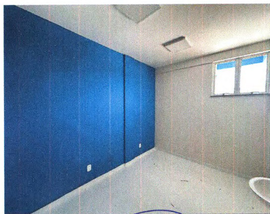
PINTURA E LUMINÁRIAS
