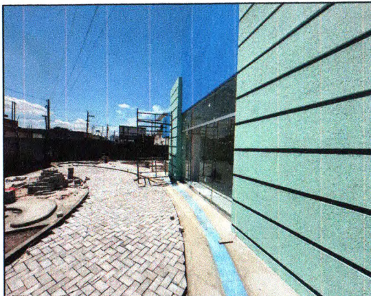
PINTURA EXTERNA, PORTA DE VIDRO, CALÇADAS, PISO INTERTRAVADO E PISO PODOTÁTIL
