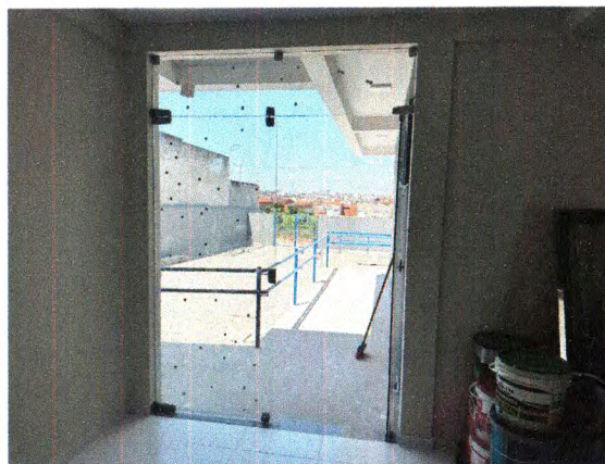
PORTA DE VIDRO, PINTURA E LUMINÁRIAS
