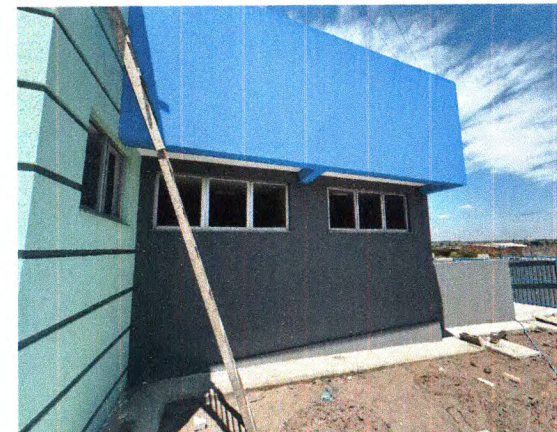
PINTURA EXTERNA E CALÇADAS
