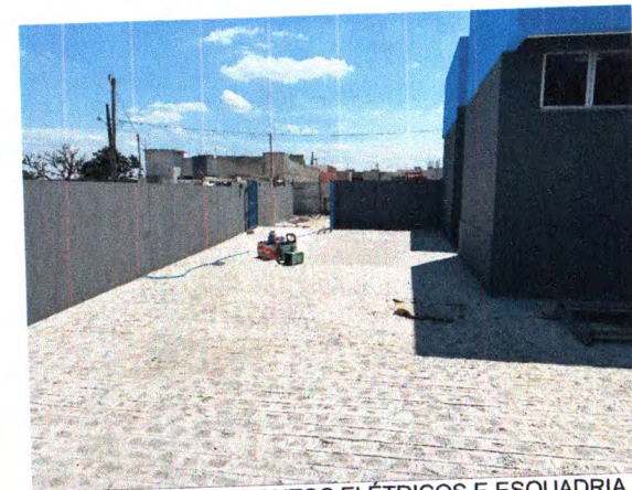
EMASSAMENTO, PONTOS ELÉTRICOS E ESQUADRIA DE ALUMÍNIO
