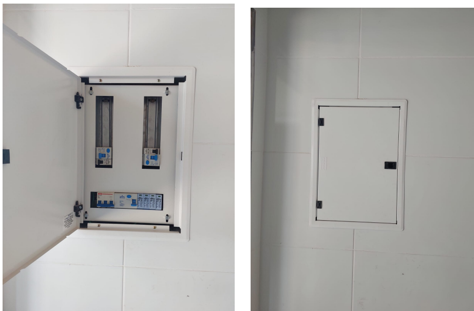
Fotos 04. Instalação de disjuntores em quadro de energia
