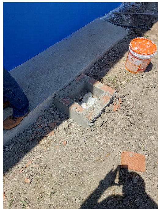
Fotos 09. Pintura externa do bloco do refeitório; execução do passeio externo; execução de caixa de gordura e caixa de passagem; pintura de gradil e portões
