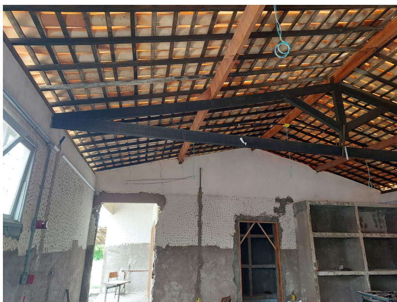
Fotos 11. Execução de madeiramento no bloco do refeitório
