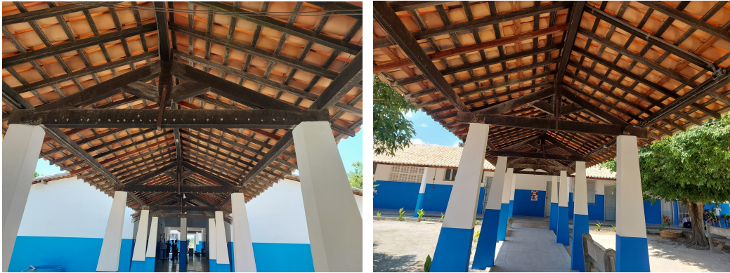
Fotos 08. Execução de madeiramento e cobertura nos telhados dos corredores; pintura dos pilares dos corredores; execução de rampas de acesso aos blocos
