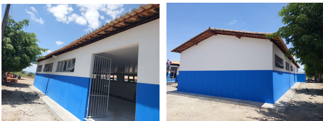
Fotos 07. Emassamento de cumieira, emassamento de beirais, passeio externo e pintura externa do bloco do refeitório e corredores
