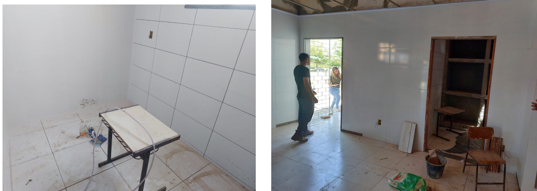
Fotos 06. Execução de revestimentos e pisos e aplicação de rejunte
