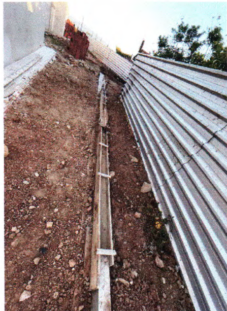
Figura 04: Execução de armação dos pilares e montagem das fôrmas para concretagem.
