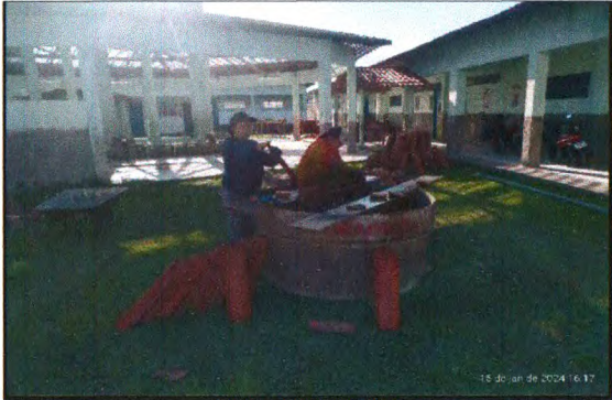
LAVAGEM DE TELHAS
