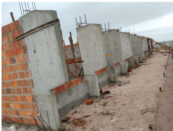
FORMAS, FERRAGEM, CONCRETO - PILARES; CHAPISCO
