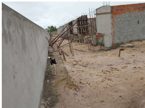
FORMAS, FERRAGEM, CONCRETO - PILARES; CHAPISCO
