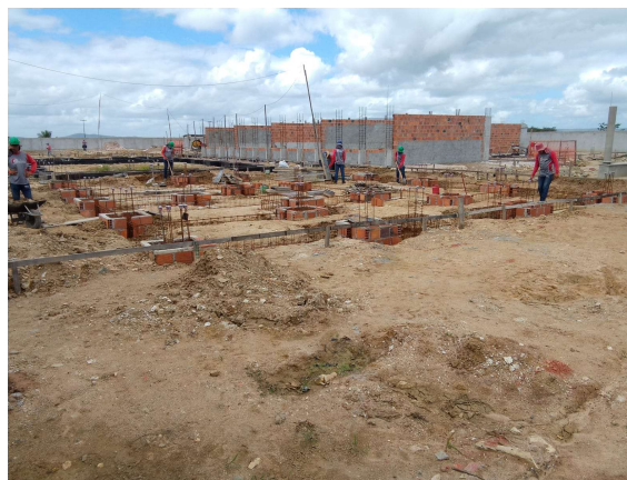
FORMAS, FERRAGEM, CONCRETO - BLOCOS; ARRANQUE DE PILARES; VIGAS BALDRAME
