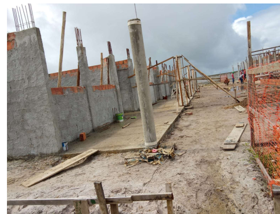
FORMAS, FERRAGEM, CONCRETO - PILARES; CHAPISCO
