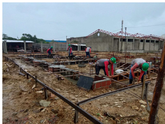
FORMAS, FERRAGEM, CONCRETO - BLOCOS; ARRANQUE DE PILARES; VIGAS BALDRAME
