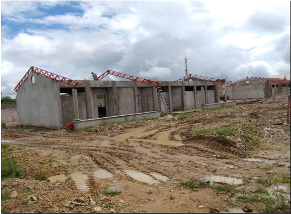
COBERTURA - ESTRUTURA METÁLICA
