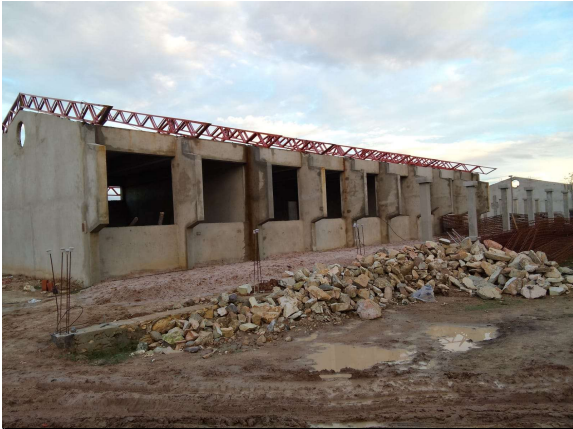
COBERTURA - ESTRUTURA METÁLICA
