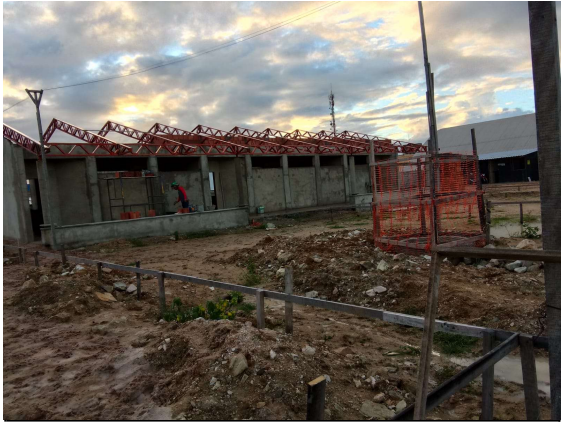
COBERTURA - ESTRUTURA METÁLICA
