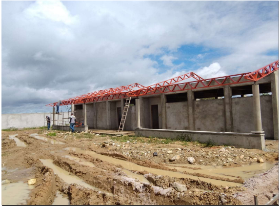
COBERTURA - ESTRUTURA METÁLICA
