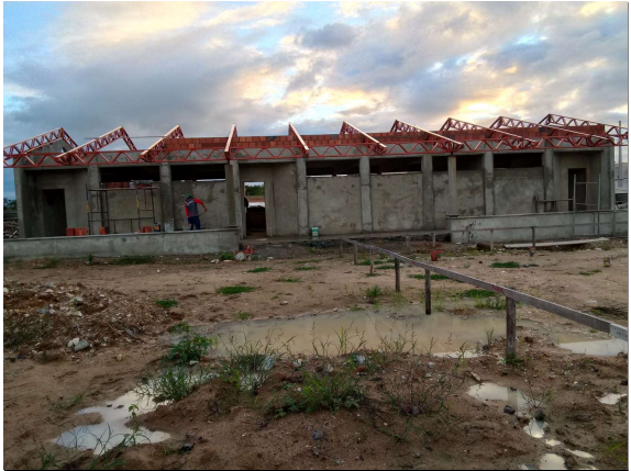
COBERTURA - ESTRUTURA METÁLICA
