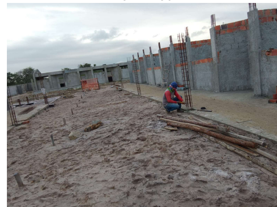
FORMAS, FERRAGEM, CONCRETO - PILARES; CHAPISCO
