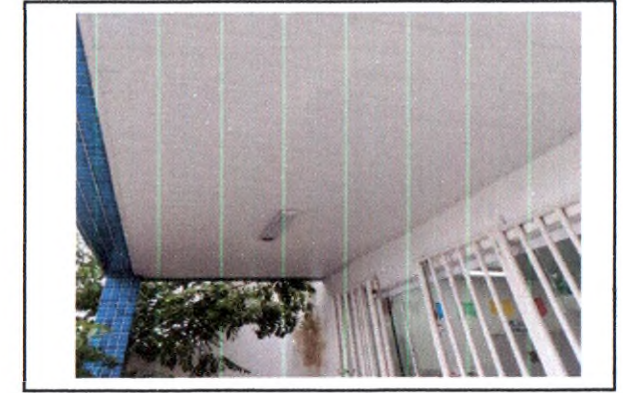
FORRO DE PVC
