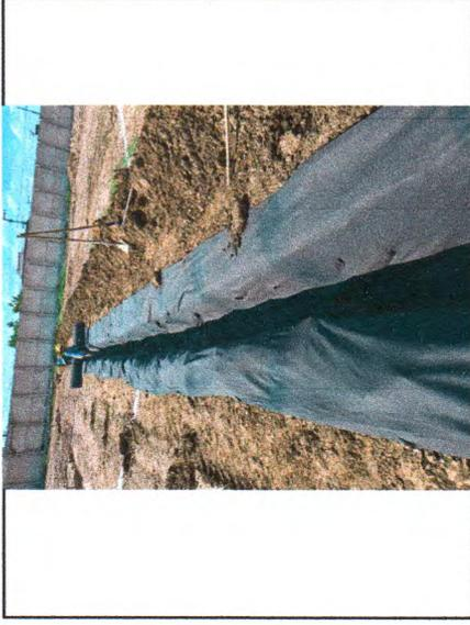
ESCAVAÇÃO E MANTA GEOTEXTIL DAS TRINCHEIRAS PARA A DRENAGEM
