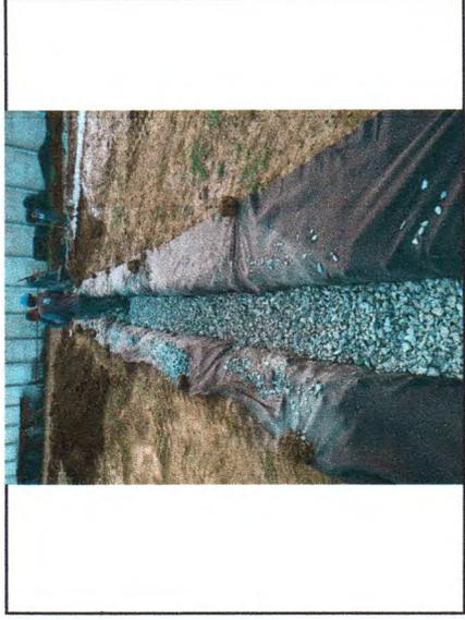
ESCAVAÇÃO, MANTA GEOTEXTIL, LASTRO DE BRITA E TUBO CORRUGADO PERFURADO DAS TRINCHEIRAS PARA A DRENAGEM
