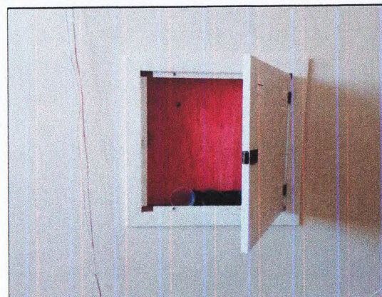
CAIXA DE PASSAGEM
