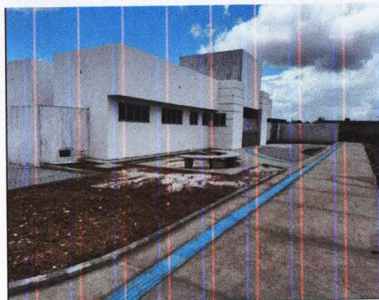
EMASSAMENTO E PINTURA
