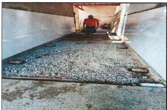
DEMOLIÇÃO ALTA RESISTÊNCIA
