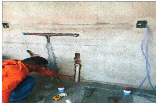
PONTO DE ESGOTO
