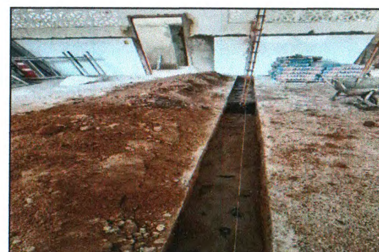
DEMOLIÇÃO MANUAL DE PISO
