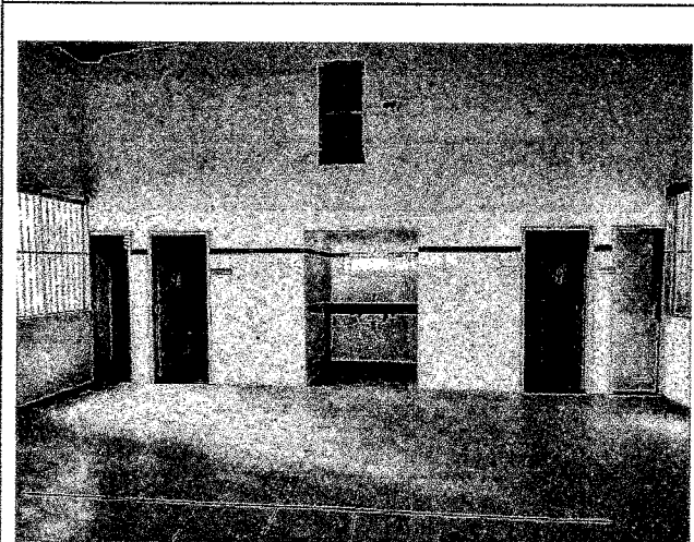
Foto 31. Vista do acesso aos banheiros no terceiro andar.
