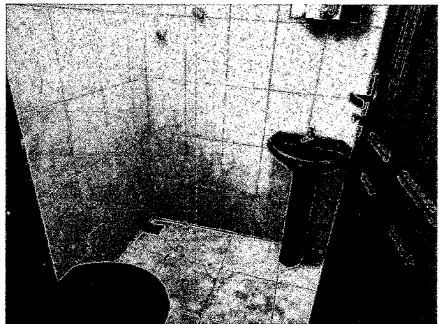
Foto 24. Vista de um banheiro no segundo andar.
