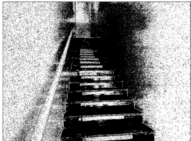
Foto 16. Vista da escada de acesso ao primeiro andar.
