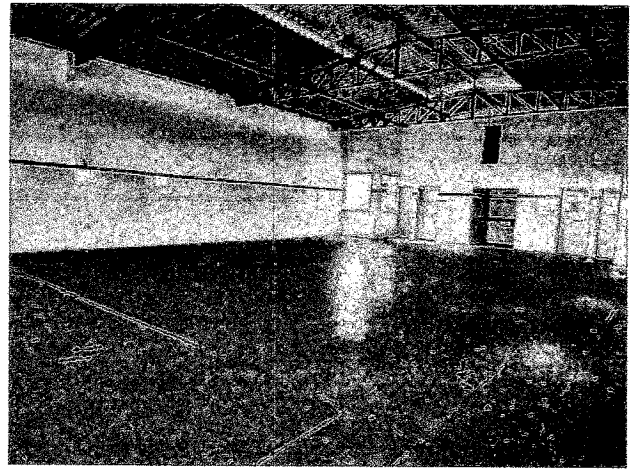
Foto 30. Vista da área livre extensa no terceiro andar.
