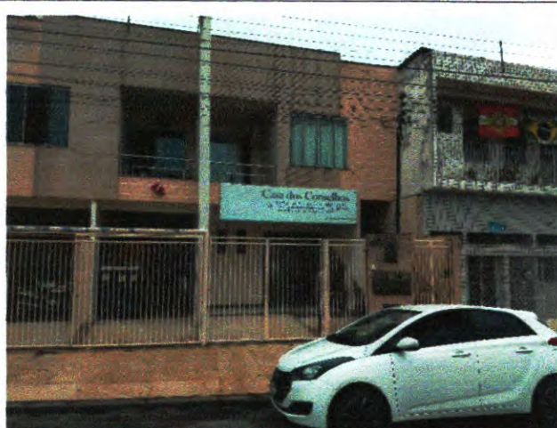
Foto 1. Vista da fachada do imóvel avaliando.
