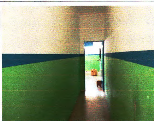
Foto 2. Vista do corredor.
