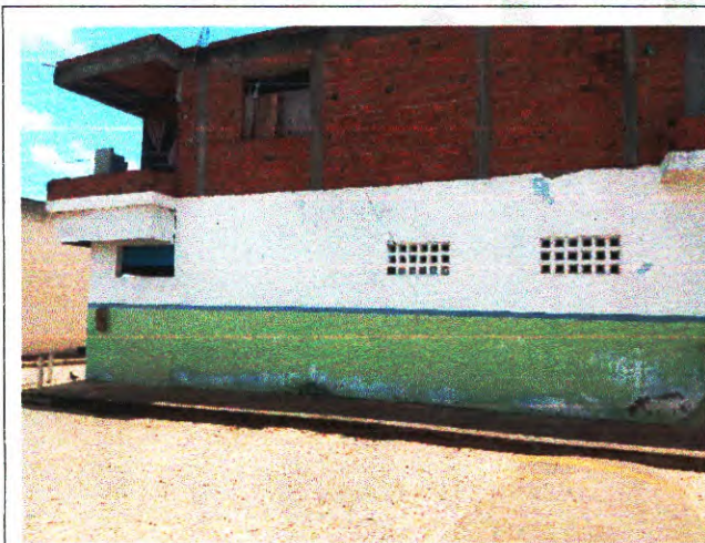
Foto 1. Vista da fachada frontal do imóvel avaliando.
