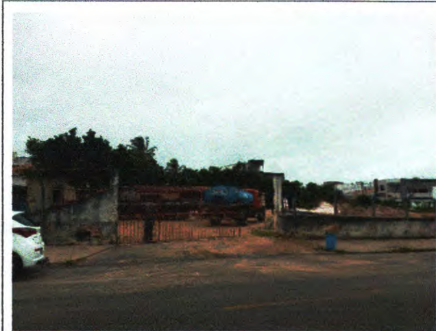
Foto 1. Vista da fachada do imóvel avaliando.
