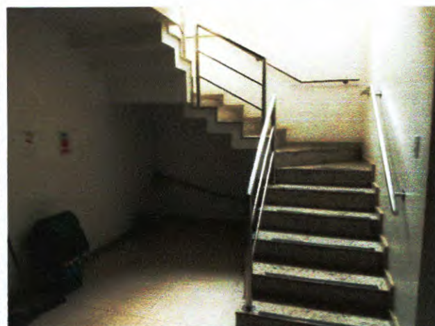
Foto 7. Vista da escada de acesso ao 3º pavimento.
