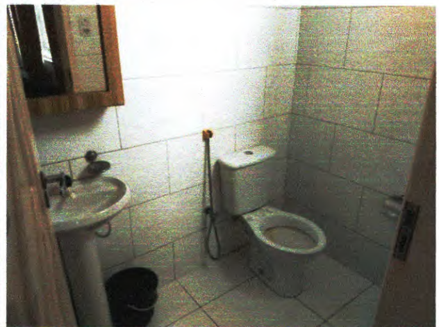
Foto 12. Vista de um banheiro.
