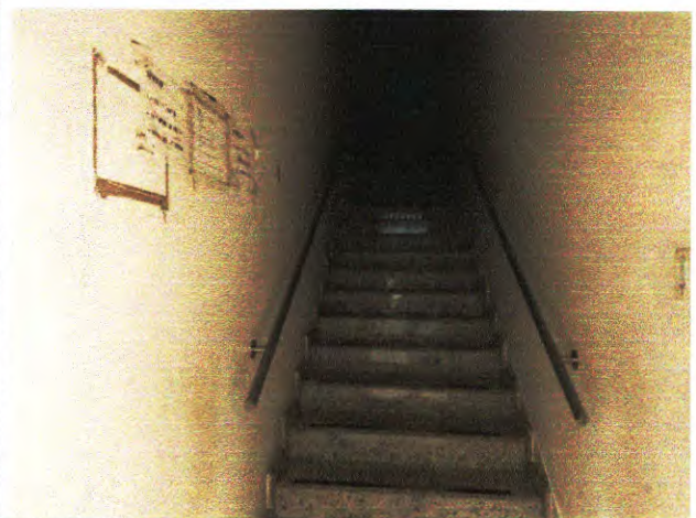
Foto 4. Vista da escada de acesso ao 2º pavimento.
