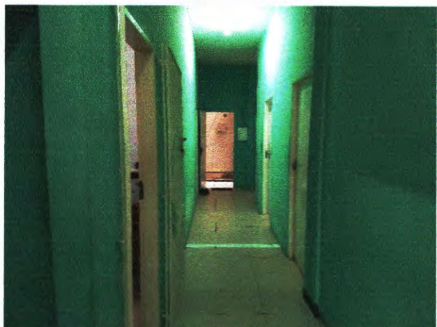
Foto 3. Vista do corredor.
