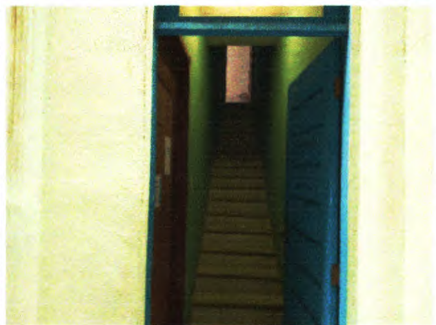
Foto 5. Vista da escada.
