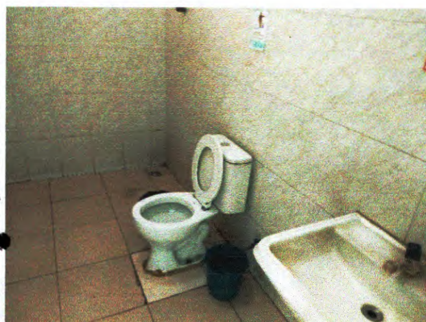
Foto 4. Vista de um banheiro.
