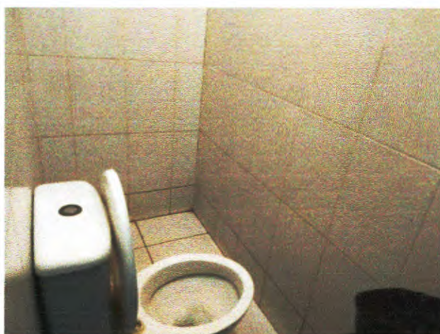
Foto 8. Vista de um banheiro.
