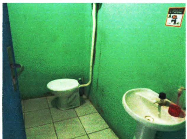
Foto 7. Vista de um banheiro.
