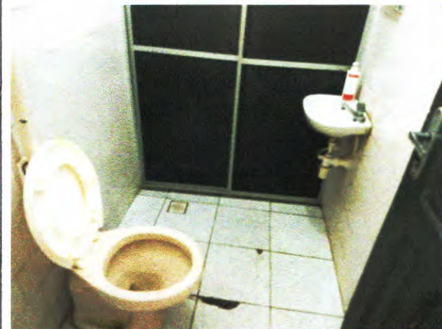
Foto 11. Vista de um banheiro
