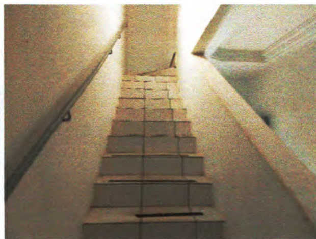
Foto 6. Vista da escada de acesso ao segundo pavimento.
