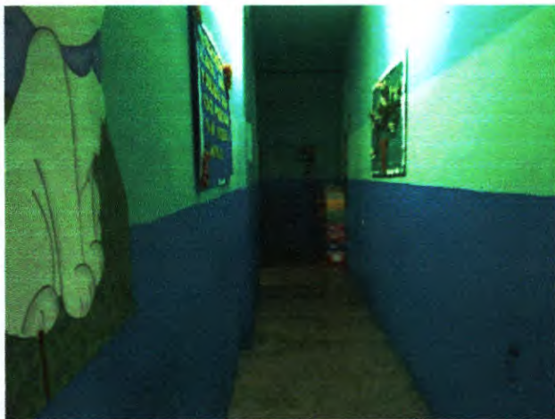
Foto 9. Vista do corredor.
