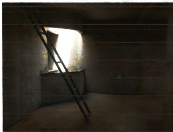
Foto 13. Vista de uma sala do andar superior.
