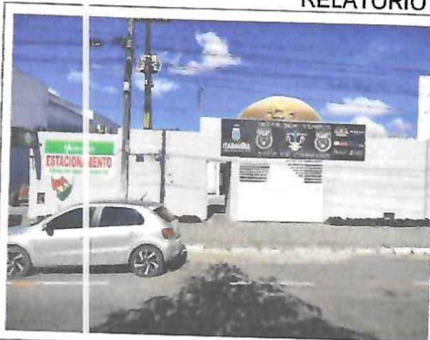
Foto 1. Vista da fachada do imóvel avaliando.
