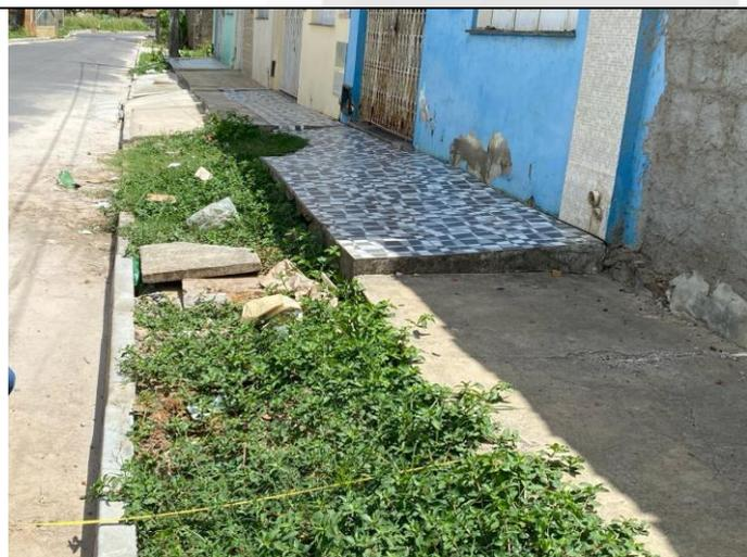
*Foto 03: Calçadas com desníveis e sem largura mínima adotada por norma (sem acessibilidade)*
