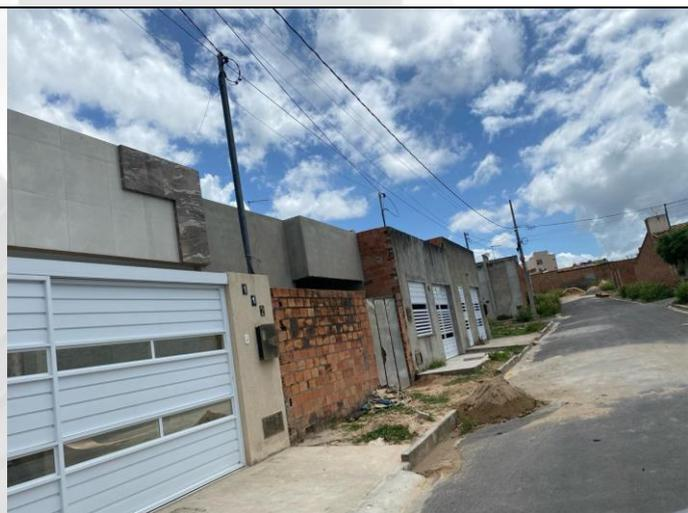
*Foto 04: Calçadas com desníveis e sem largura mínima adotada por norma (sem acessibilidade)*
