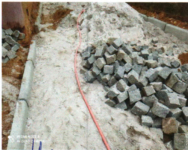
Foto 03: PAVIMENTAÇÃO DO TRECHO 04
