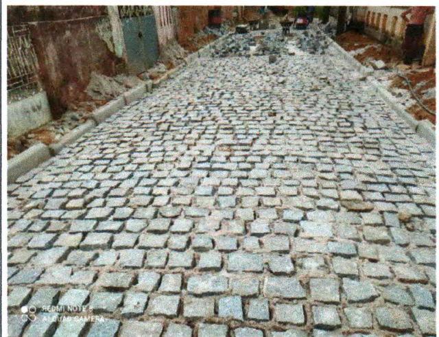
Foto 04: PAVIMENTAÇÃO DO TRECHO 04
