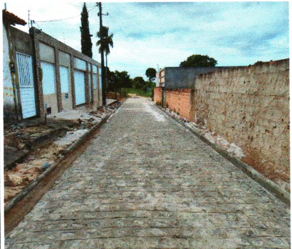
Foto 10: PAVIMENTAÇÃO DO TRECHO 02
