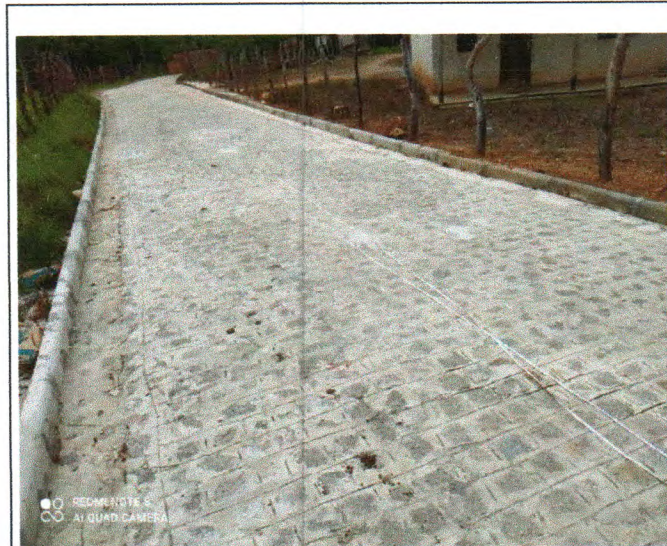
Foto 09: PAVIMENTAÇÃO DO TRECHO 02
