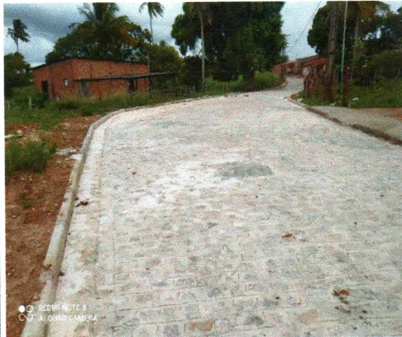
Foto 06: PAVIMENTAÇÃO DO TRECHO 03
