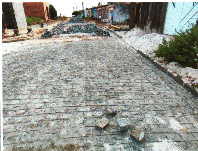
Foto 11: PAVIMENTAÇÃO DO TRECHO 01
