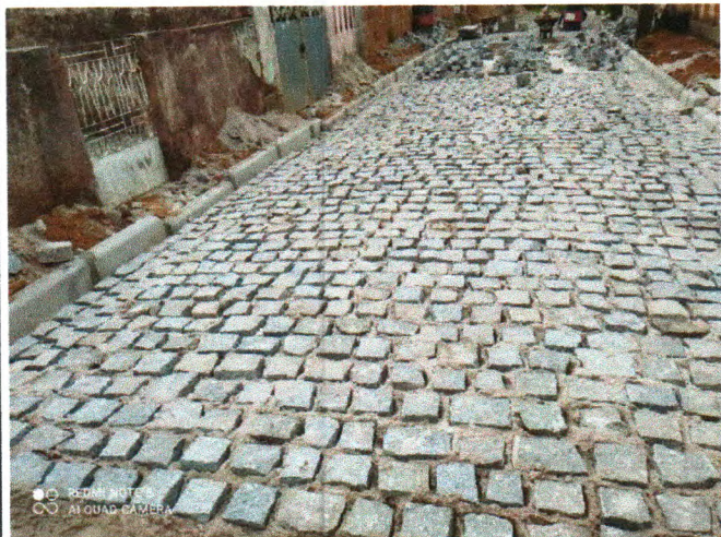
Foto 05: PAVIMENTAÇÃO DO TRECHO 03
