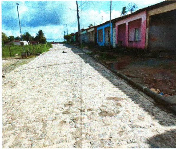
Foto 13: PAVIMENTAÇÃO DO TRECHO 01
