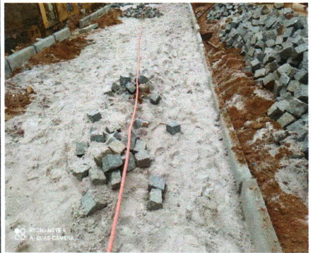
Foto 02: PAVIMENTAÇÃO DO TRECHO 04
