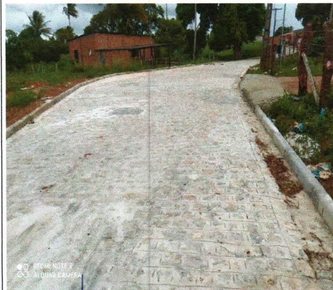
Foto 07: PAVIMENTAÇÃO DO TRECHO 03
