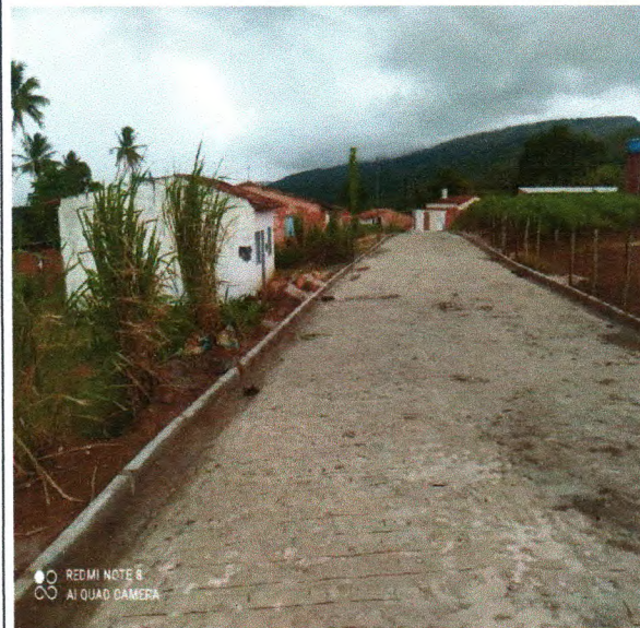
Foto 08: PAVIMENTAÇÃO DO TRECHO 02
