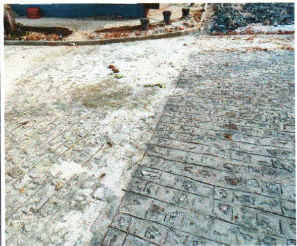
Foto 12: PAVIMENTAÇÃO DO TRECHO 01
